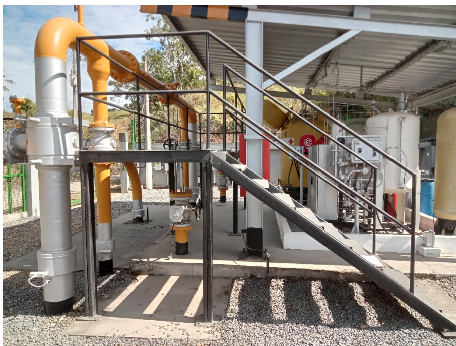
Foto 5: Plataforma de acesso à tubulação.
