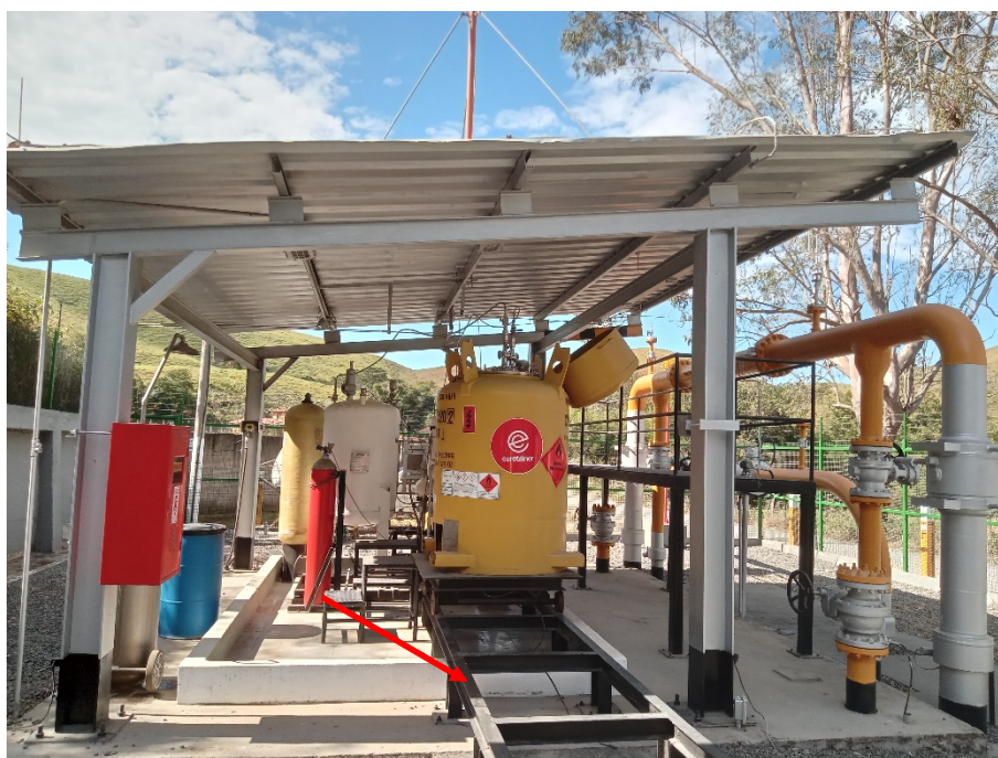
Foto 10: Plataforma para deslocamento do tanque.
