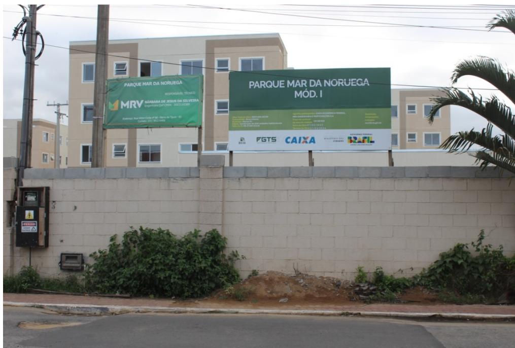
Foto 1: Empreendimento a ser atendido
