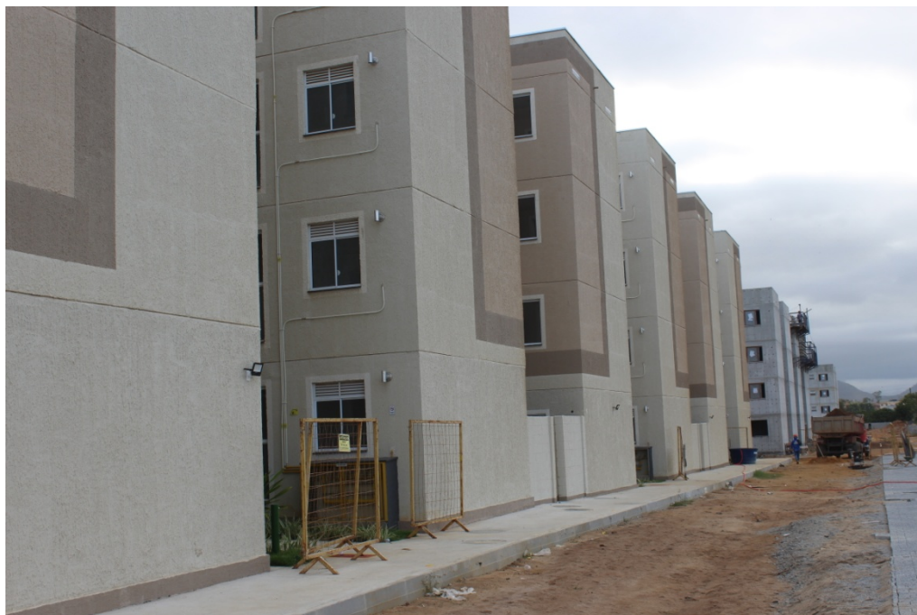
Foto 6: Blocos do condomínio em construção
