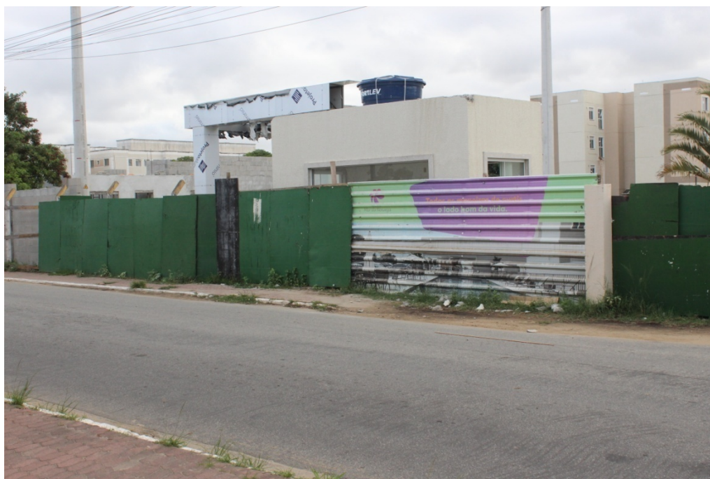
Foto 2: Portal do condomínio ainda em construção
