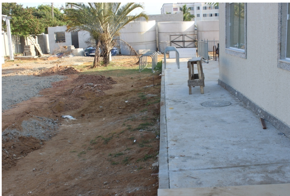
Foto 4: Trecho de rede construída sinalizado com marco plano
