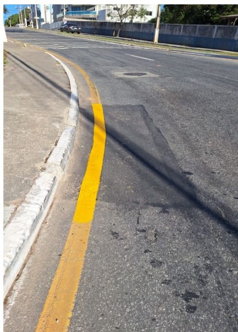
Foto 14: Adequação de pintura da faixa.
