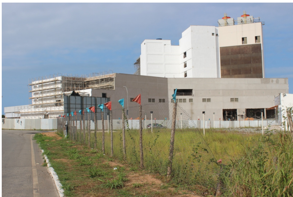
Foto 10: Empreendimento a ser atendido (Hospital Macaé D'or).
