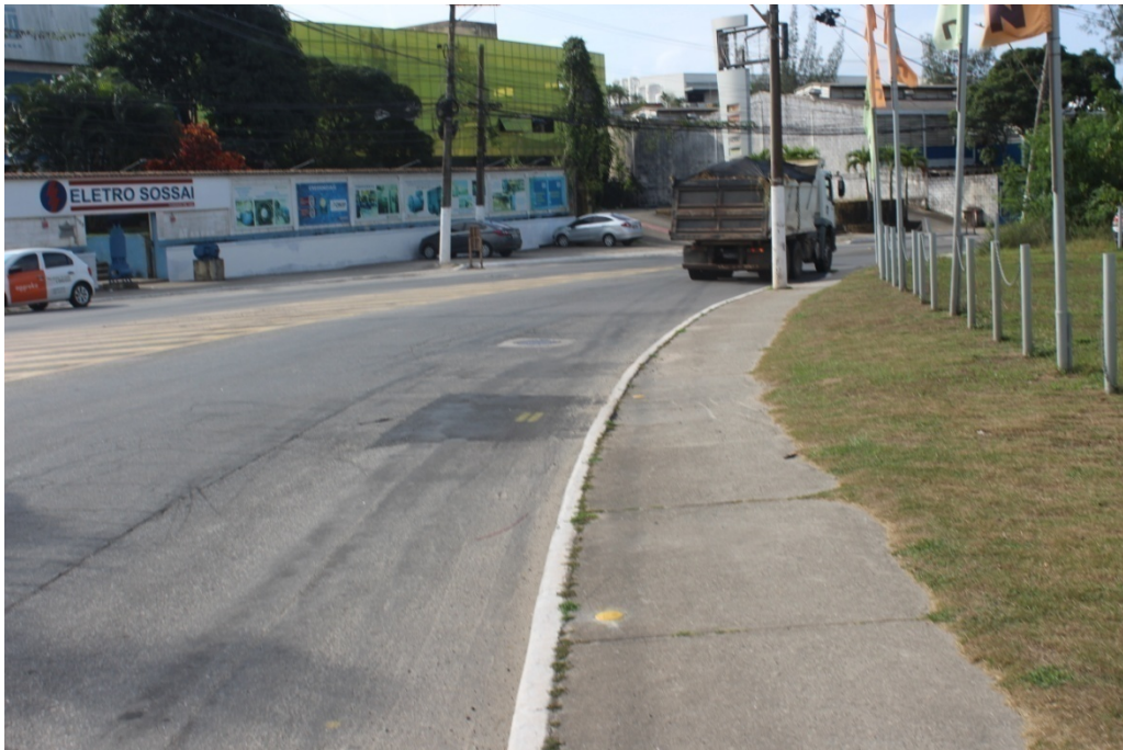
Foto 5: Recomposição provisória em local onde houve abertura.
