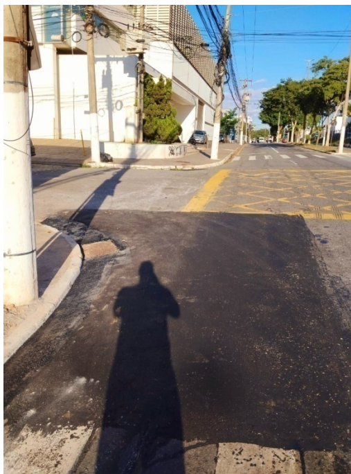
Foto 13: Reparo da pavimentação refeito.
