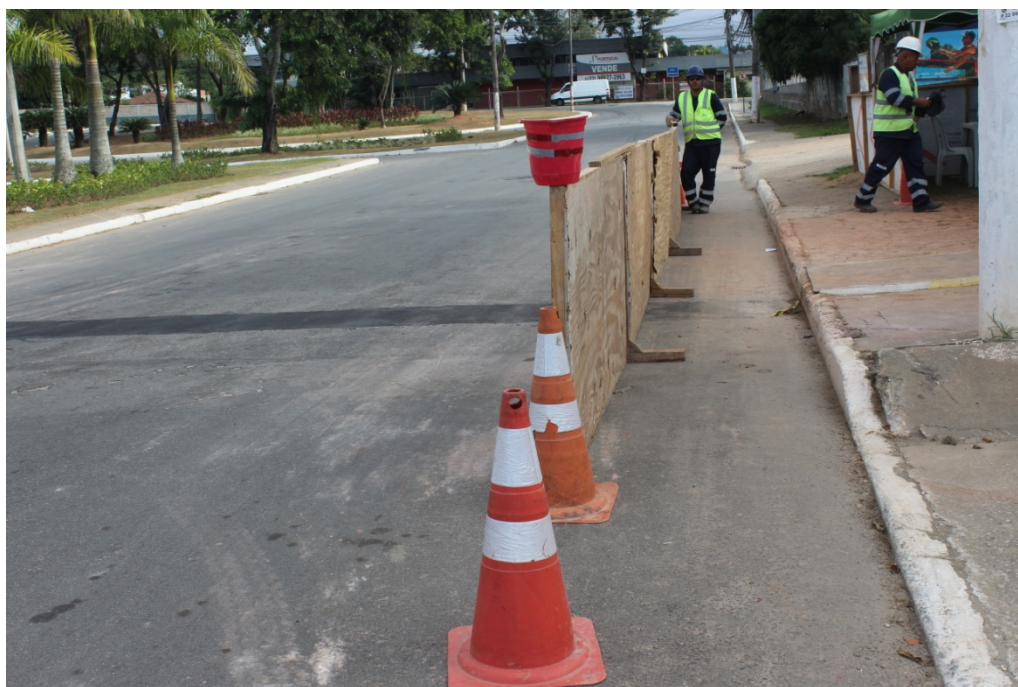
Foto 12: Adequação da sinalização noturna.
