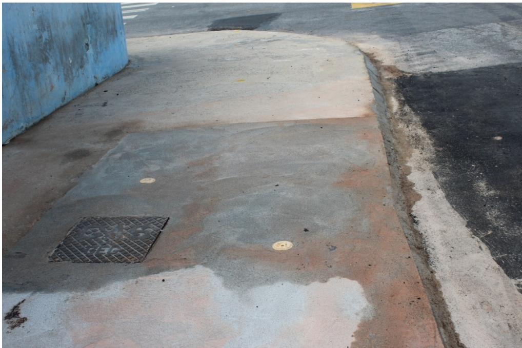
Foto 2: Ponto de reinício da obra.
