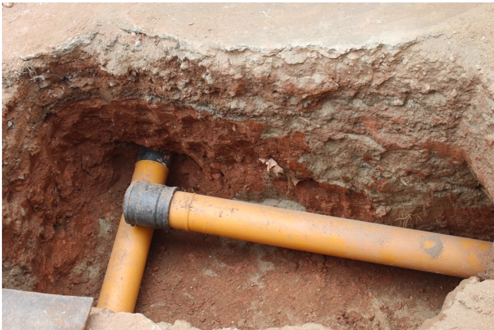
Foto 8: Tubulação PE \varnothing 160 mm a ser conectada.
