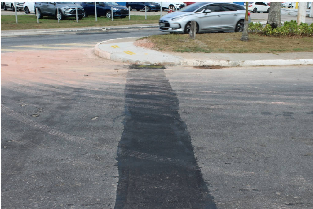
Foto 6: Local onde será realizada travessia de rede na pista em sentido contrário.
