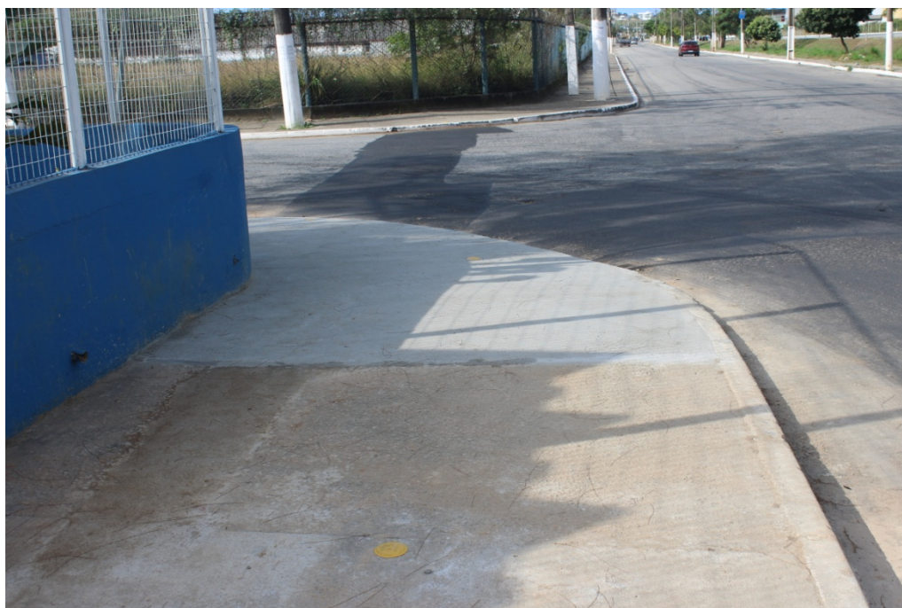
Foto 9: Recomposição do passeio e travessia de rede.
