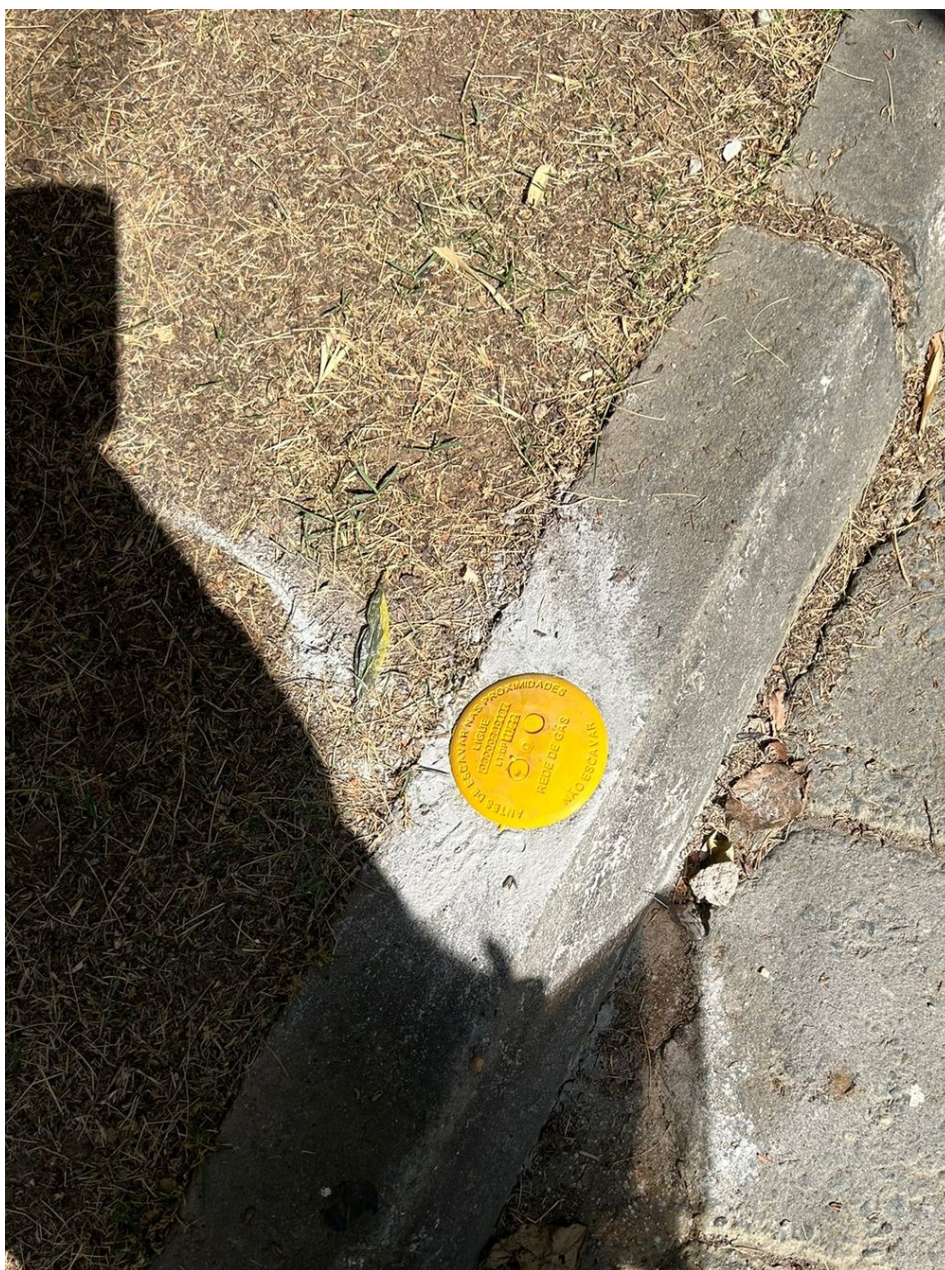
Foto 4: Sinalização da rede no passeio reconstituído
