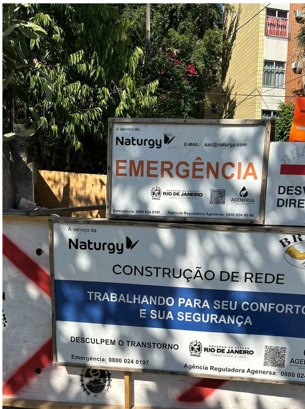
Foto 5: Tapume e identificação da área em obra
