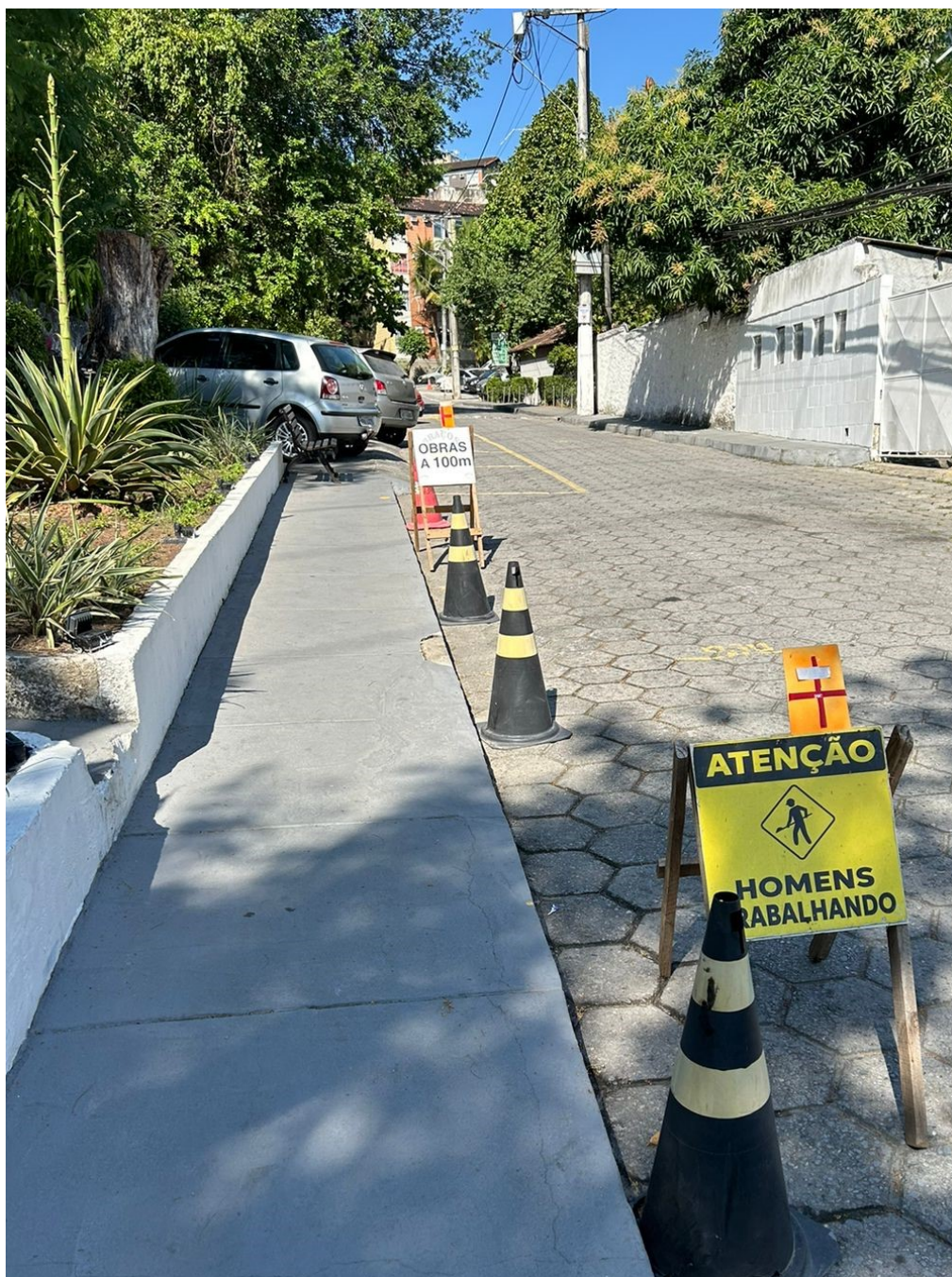
Foto 1: Sinalização do acesso.
