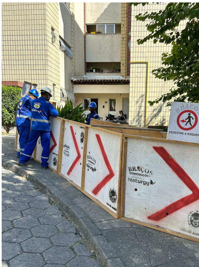
Foto 6: Sinalização do local de obra
