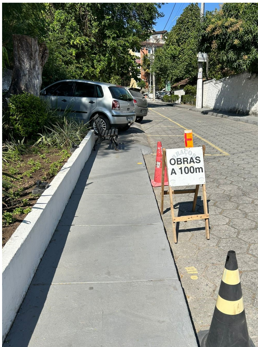
Foto 2: Sinalização do acesso.
