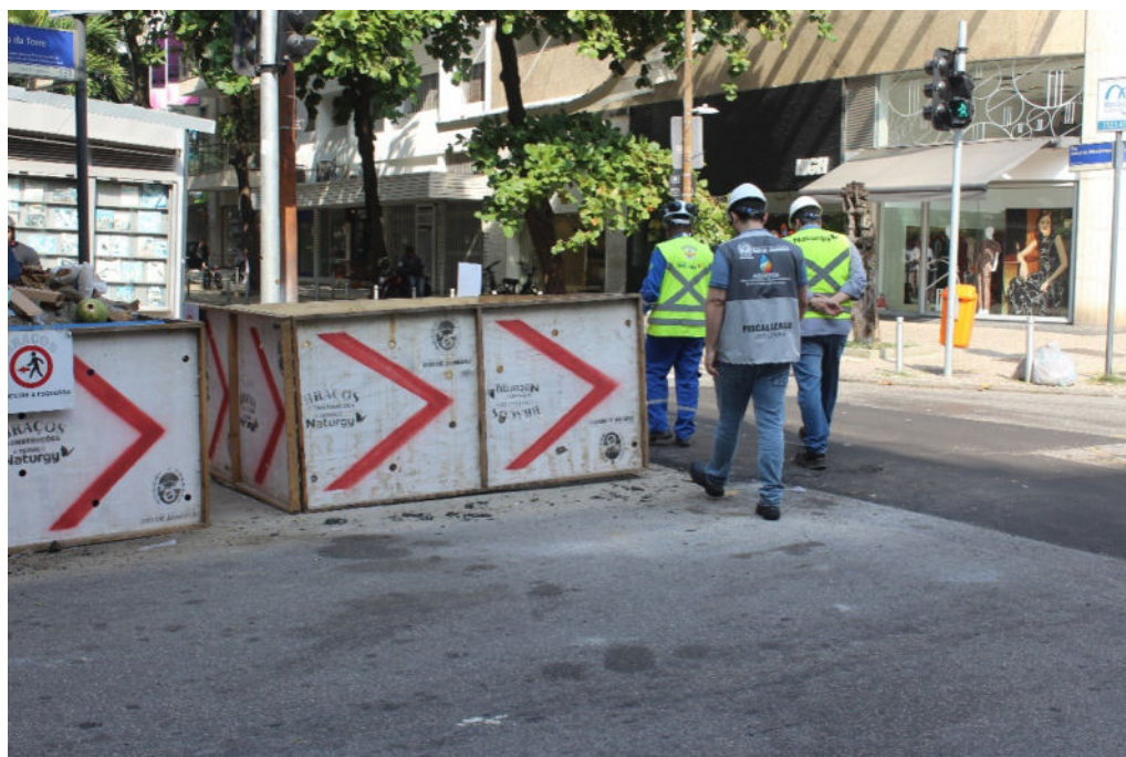
Foto 4: Trecho de obra em inspeção
