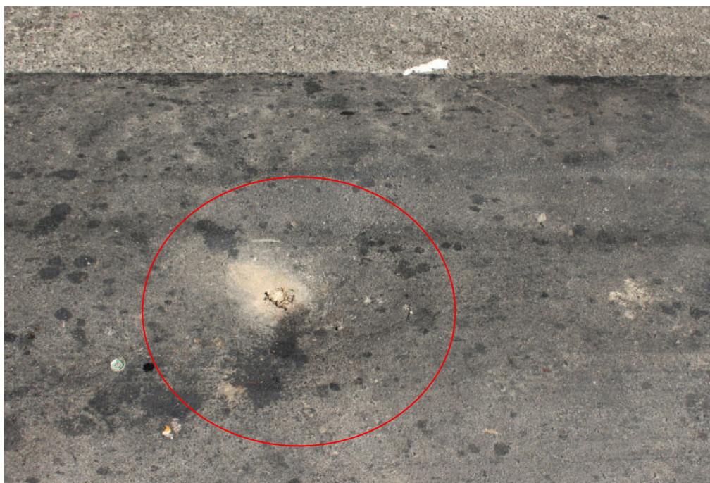
Foto 8: Recomposição com um rebaixamento no asfalto.
