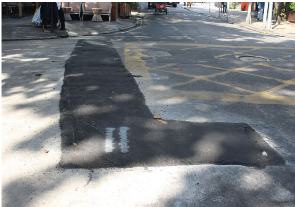
Foto 5: Trecho de recomposição provisória em local de travessia de rede.
