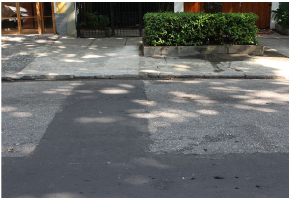
Foto 6: Trecho de recomposição da via.
