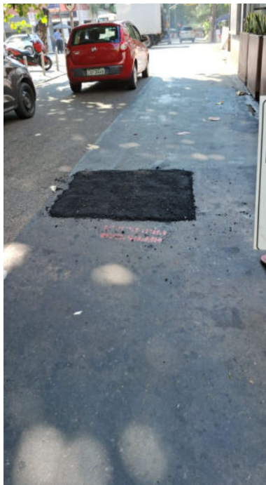
Foto 12: Adequação de recomposição em local onde havia um rebaixamento.
