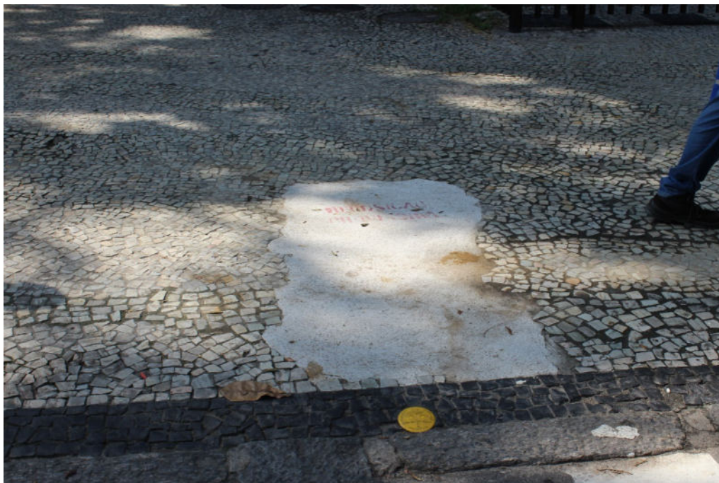
Foto 3: Recomposição provisória do passeio.
