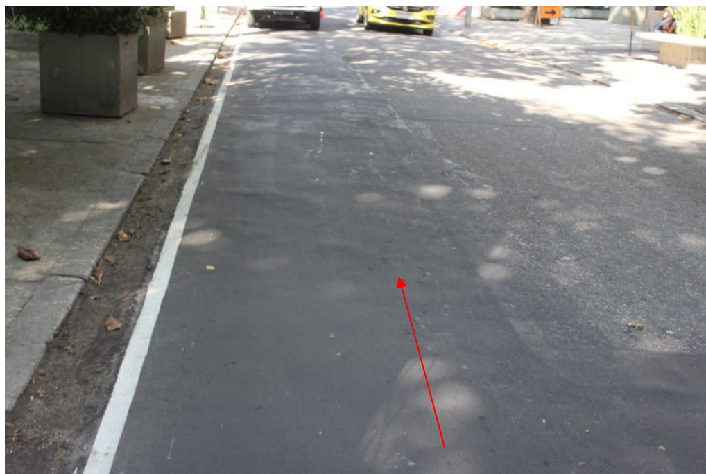
Foto 2: Ponto de início da obra com asfalto recomposto (lado ímpar).
