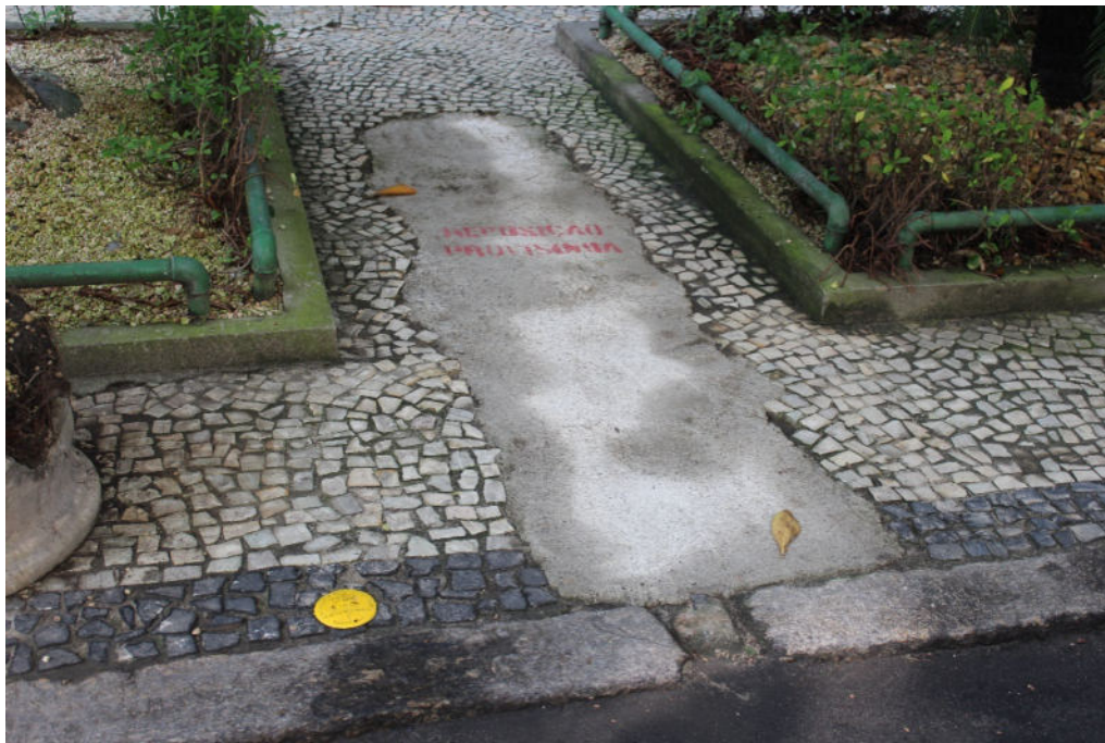
Foto 9: Recomposição provisória e marco plano.
