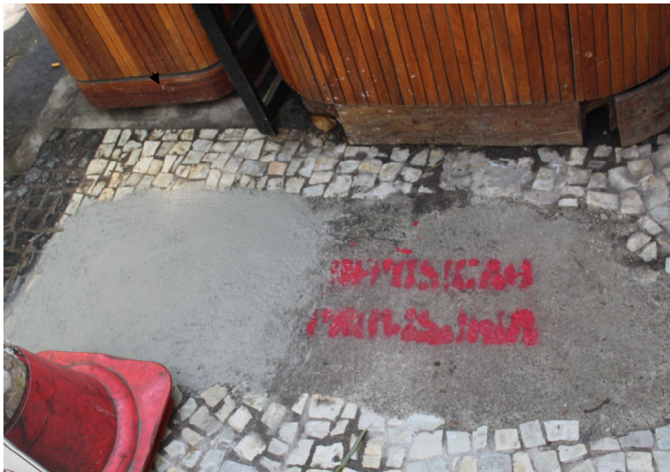
Foto 7: Recomposição provisória do passeio
