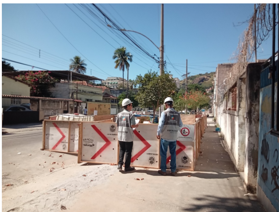
Foto 10: Trecho de obra em inspeção (Fiscalização AGENERSA).
