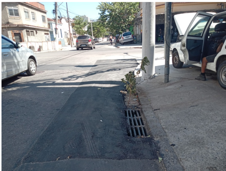
Foto 5: Trecho de recomposição da via (lado ímpar).
