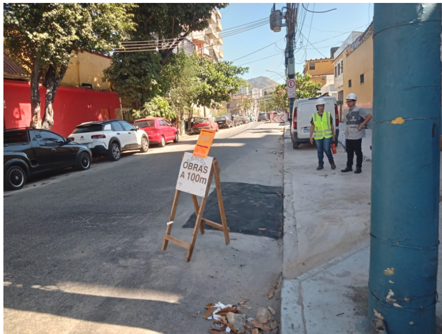
Foto 2: Ponto de início da obra (lado ímpar).
