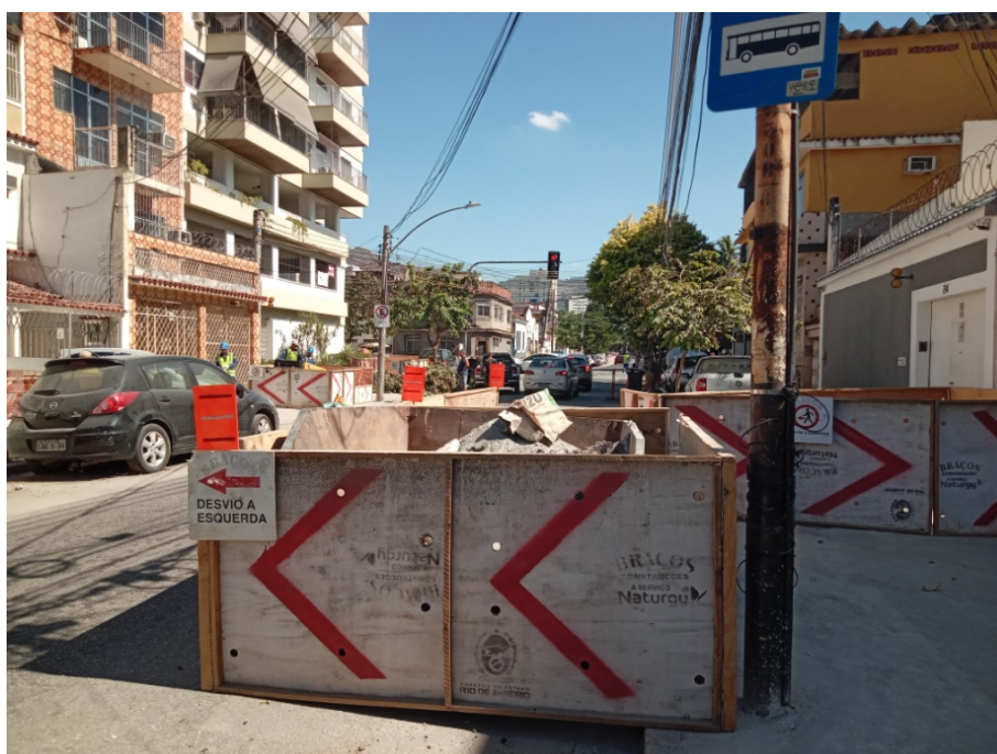
Foto 4: Isolamento em área de descarte de material (lado ímpar).
