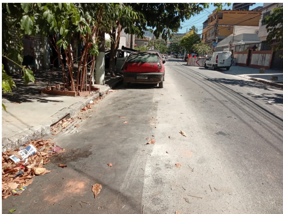
Foto 6: Trecho de recomposição da via (lado par).
