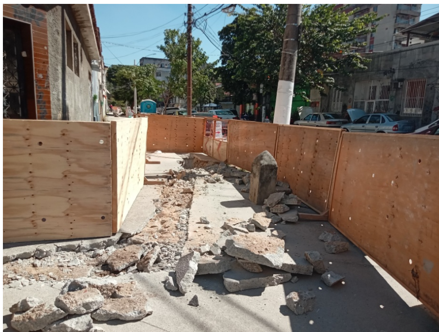
Foto 9: Abertura de vala para assentamento de tubulação (lado par).
