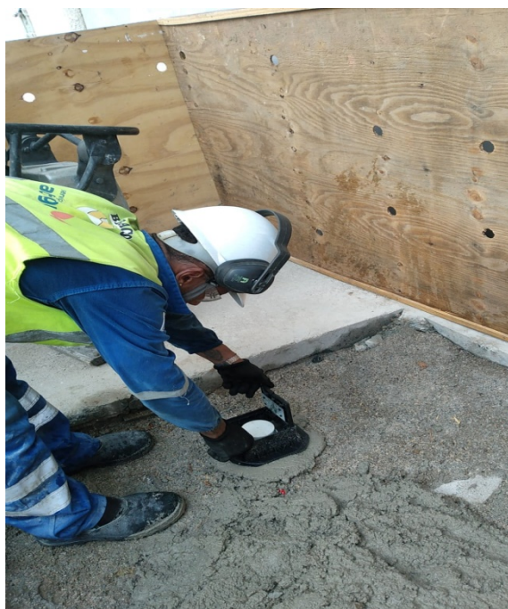
Foto 12: Realização de recomposição em local onde havia chapa de aço (lado par).
