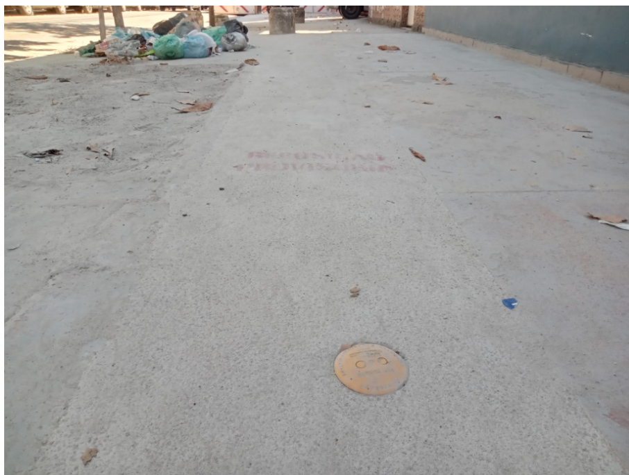
Foto 3: Recomposição provisória do passeio (lado ímpar).
