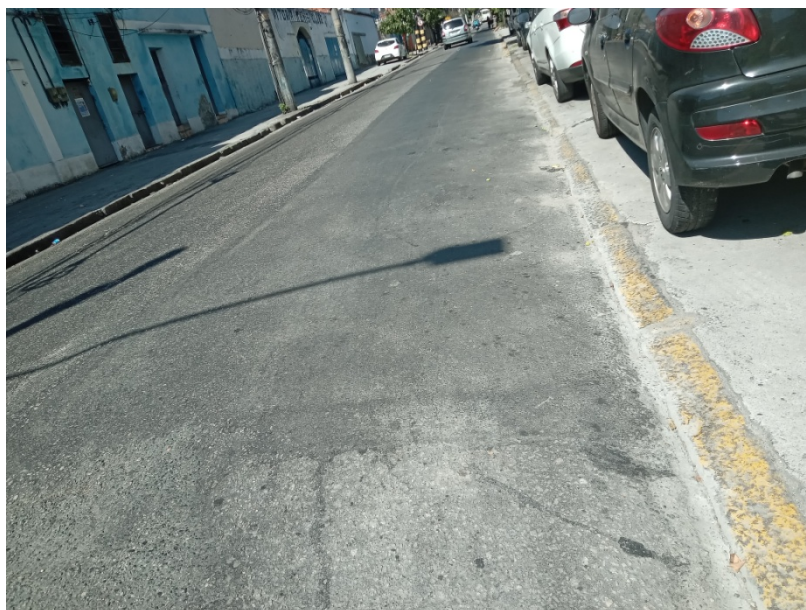
Foto 2: Trecho da via com recomposição onde a obra iniciou.
