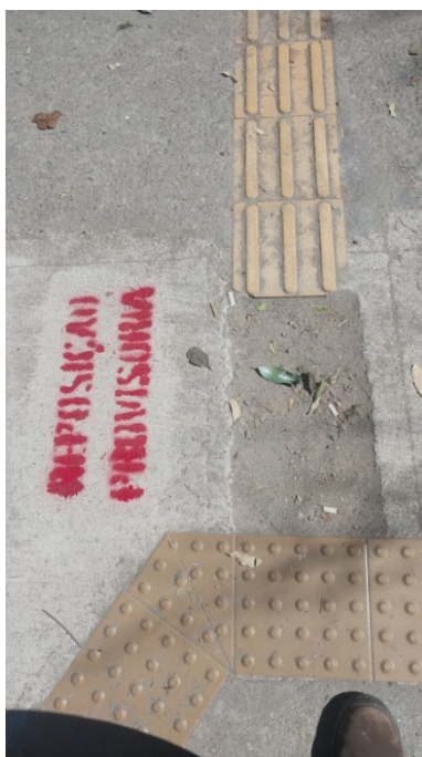
Foto 8: Aplicação de tinta com identificação de recomposição provisória.
