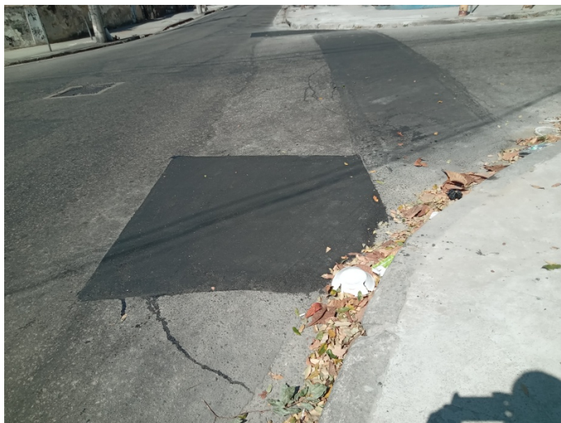
Foto 3: Ponto de interligação e travessia de rede.
