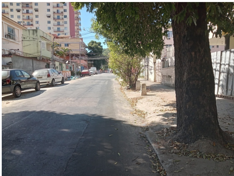
Foto 9: Trecho de recomposição da via (lado par).
