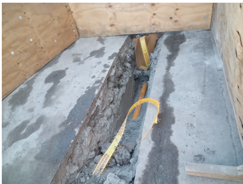
Foto 6: Tubulação assentada PE DN 90 e fita de sinalização.
