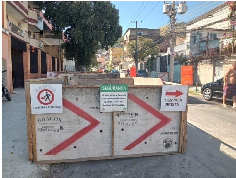
Foto 7: Local de descarte de entulho, isolamento e sinalização.
