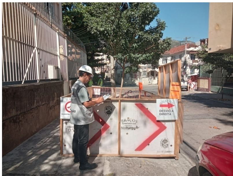
Foto 2: Ponto de início da obra com interligação em rede existente (Fiscalização AGENERSA)
