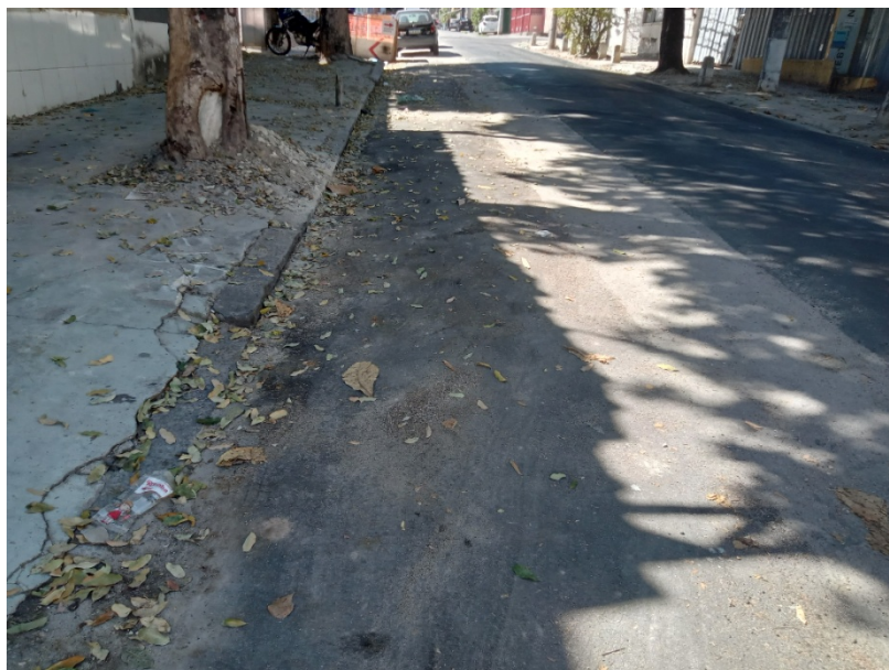
Foto 4: Trecho com recomposição da via.
