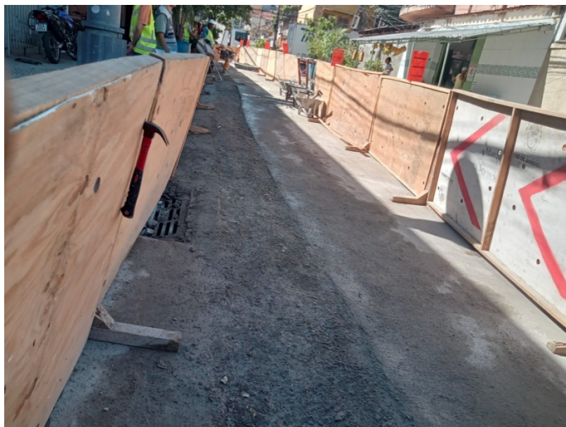
Foto 8: Trecho com recomposição sendo realizada.
