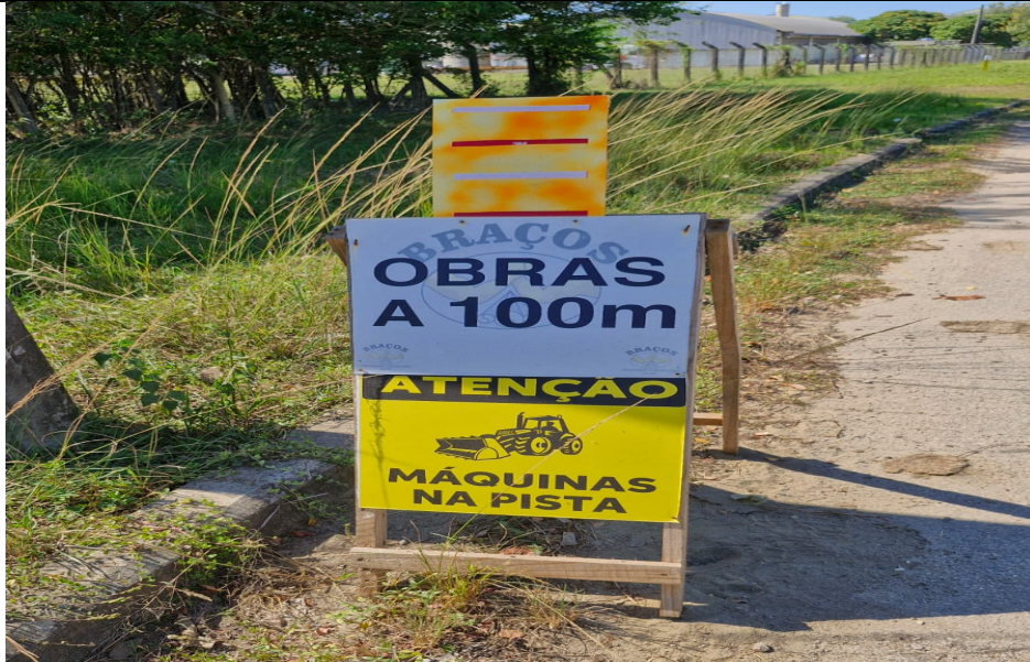
Foto 7: Sinalização da Obra, com sinalização noturna acoplada.
