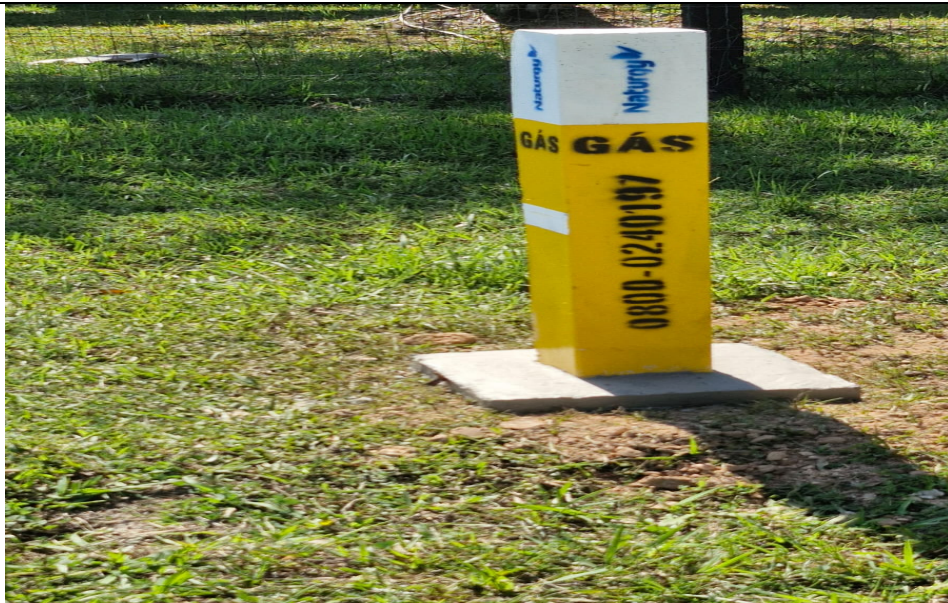
Foto 4: Marco vertical sinalizando rede finalizada, gramado recomposto.
