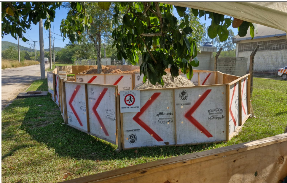
Foto 11: Área de armazenamento de material próxima ao local de convivência.
