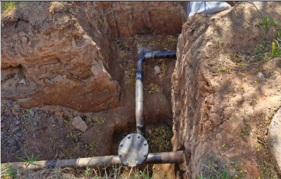
Foto 8: Tubulação em aço já em estágio de finalização.
