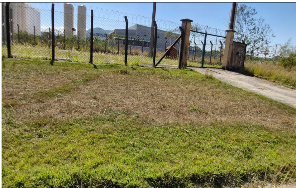
Foto 14: Logo ao lado, mesmo trecho da Avenida Bahia, mas com recomposição adequada, ainda não sinalizado.
