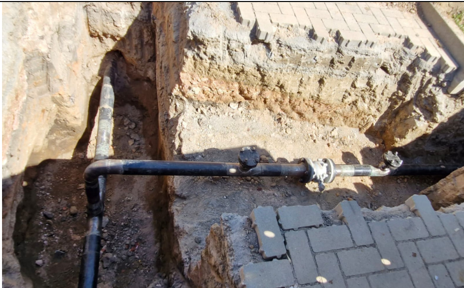
Foto 10: Ramal de aço em estágio de finalização, aguardando conexão ao cliente e testes para iniciar carga.
