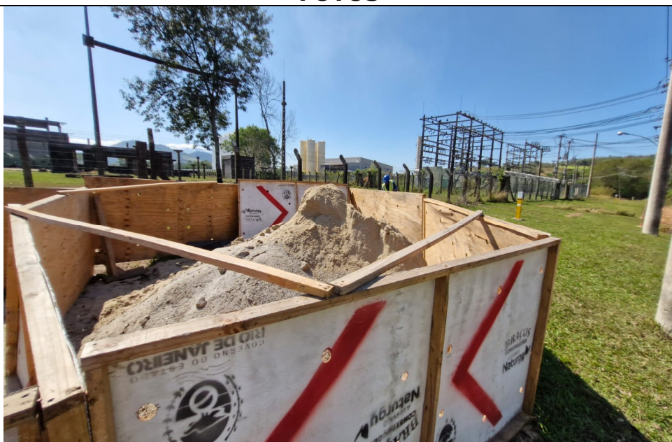
Foto 12: Terra reservada de escavação que será reaproveitada na recomposição.
