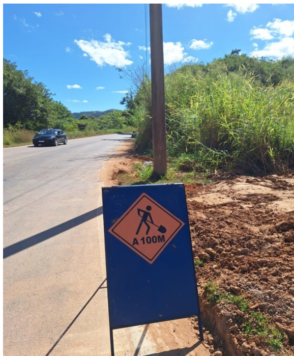
Foto 12: Adequação de sinalização de aviso de obra
