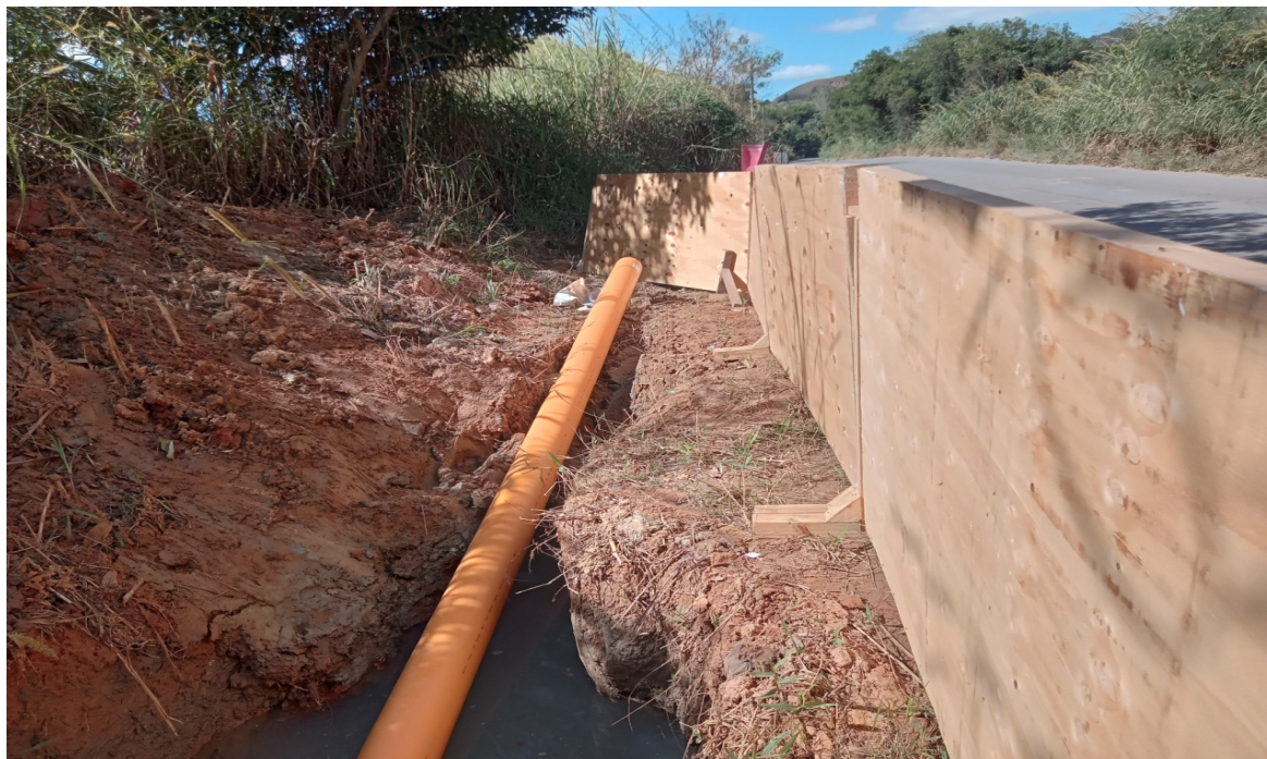
Foto 6: Ponta de rede aguardando abertura manual de vala para conexão.
