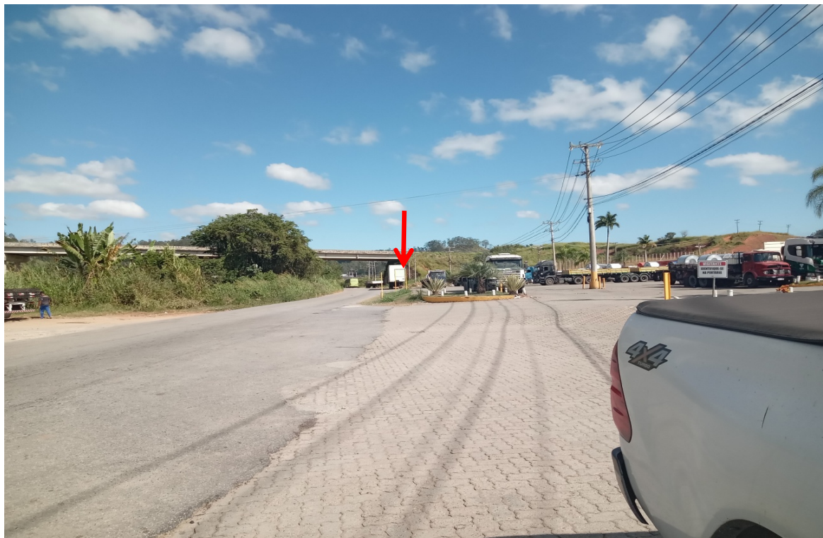
Foto 1: Ponto de início da obra local onde será realizada a interligação em rede existente
