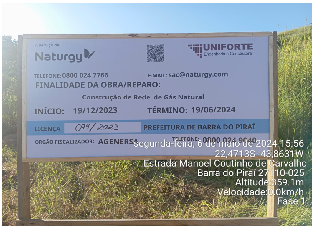
Foto 11: Adequação da placa de identificação da obra
