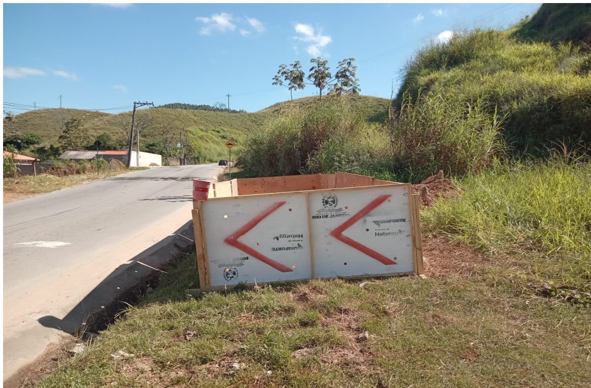
Foto 9: Isolamento de obra em área contígua à estrada
