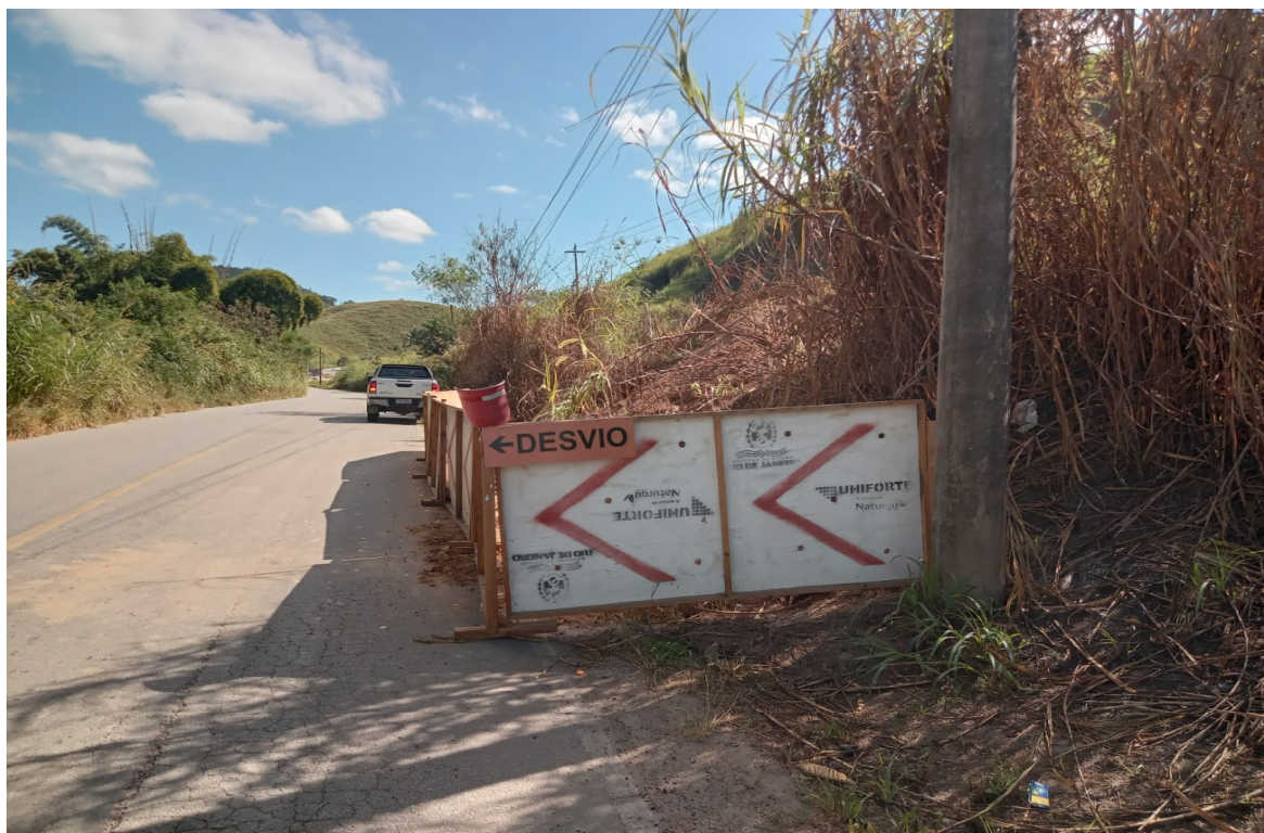
Foto 5: Isolamento de obra com tapume e sinalização
