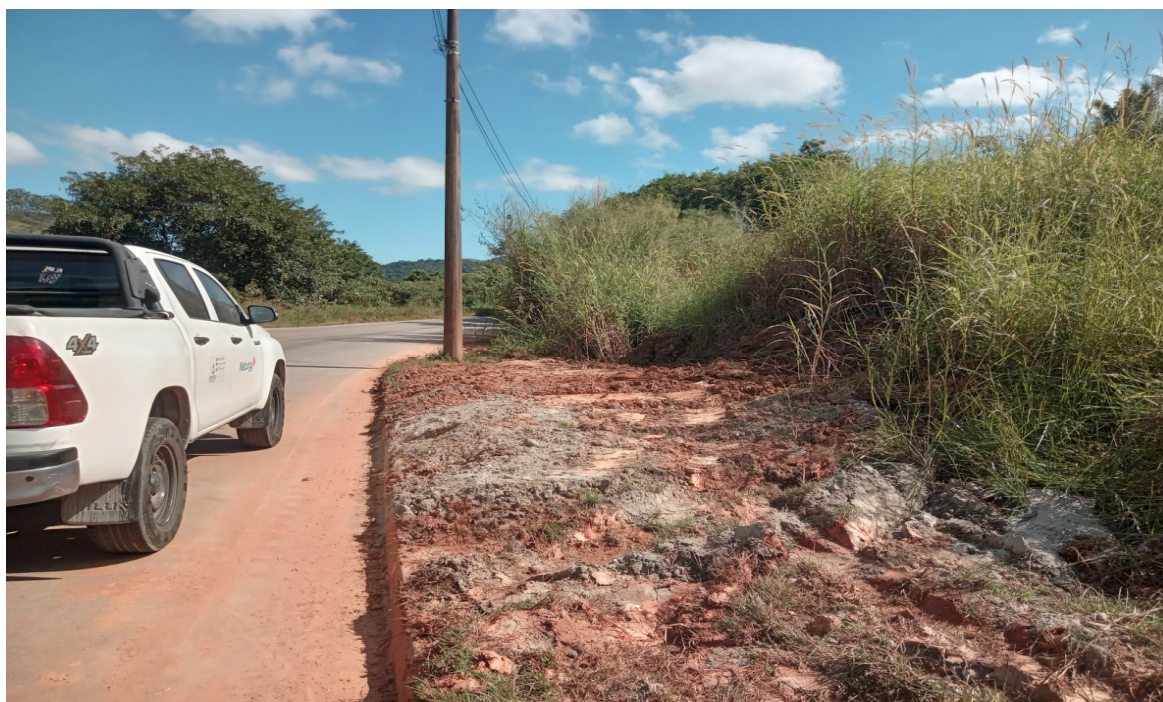
Foto 2: Local onde foi realizada abertura para passagem da tubulação de gás
