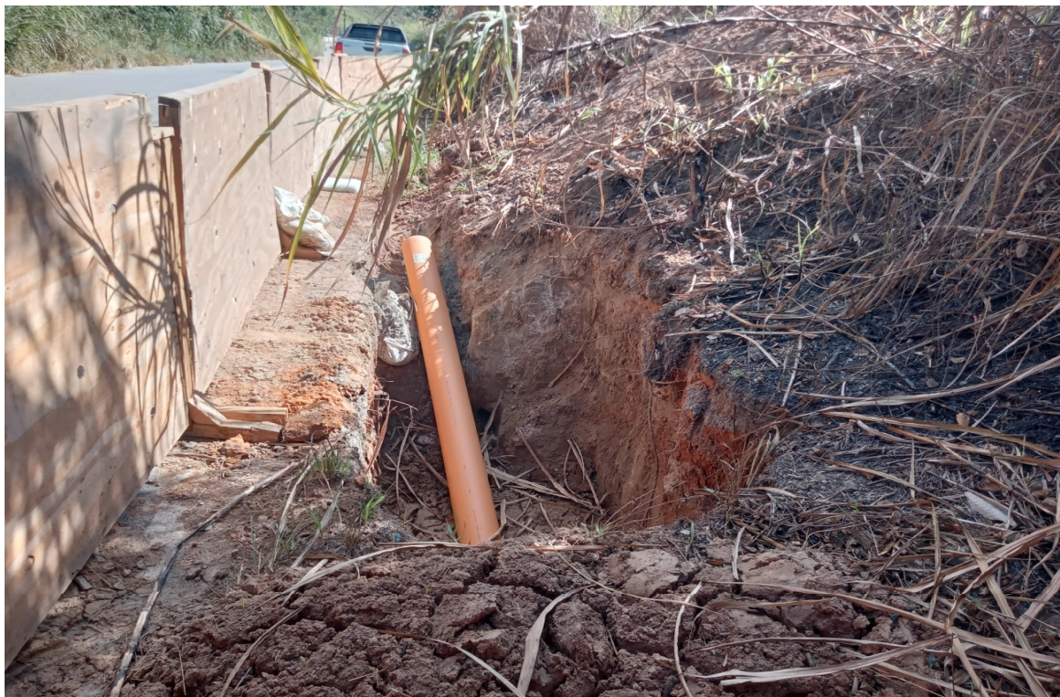
Foto 7: Local onde foi encontrado rocha, impossibilitando a perfuração com máquina
