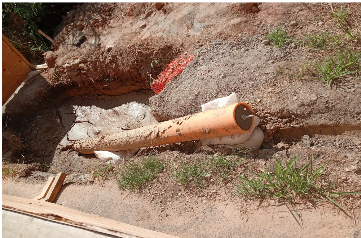
Foto 3: Tubulação de PE Ø200 mm a ser conectada a outra ponta de rede
