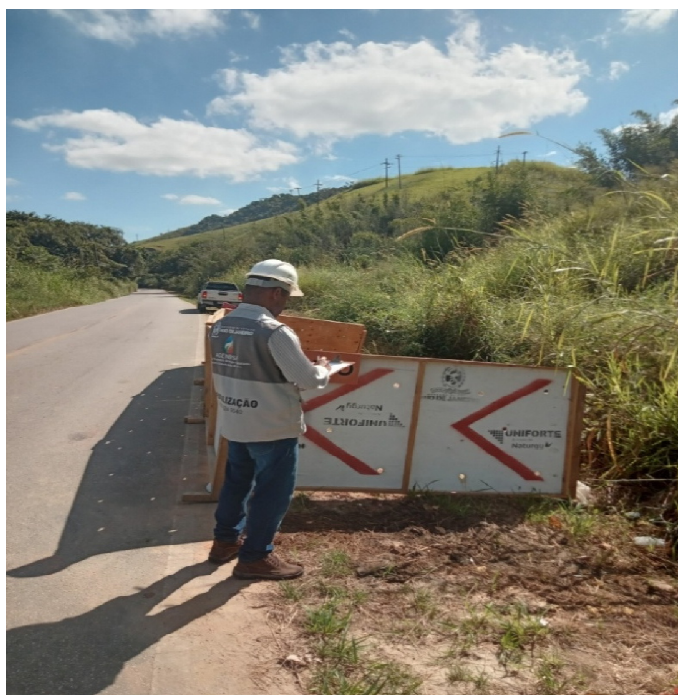
Foto 4: Inspeção em trecho de obra (AGENERSA)
