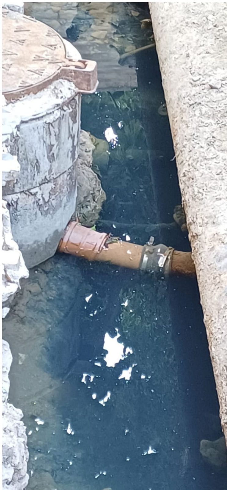
FOTO 04 – Detalhe do acoplamento ineficiente
