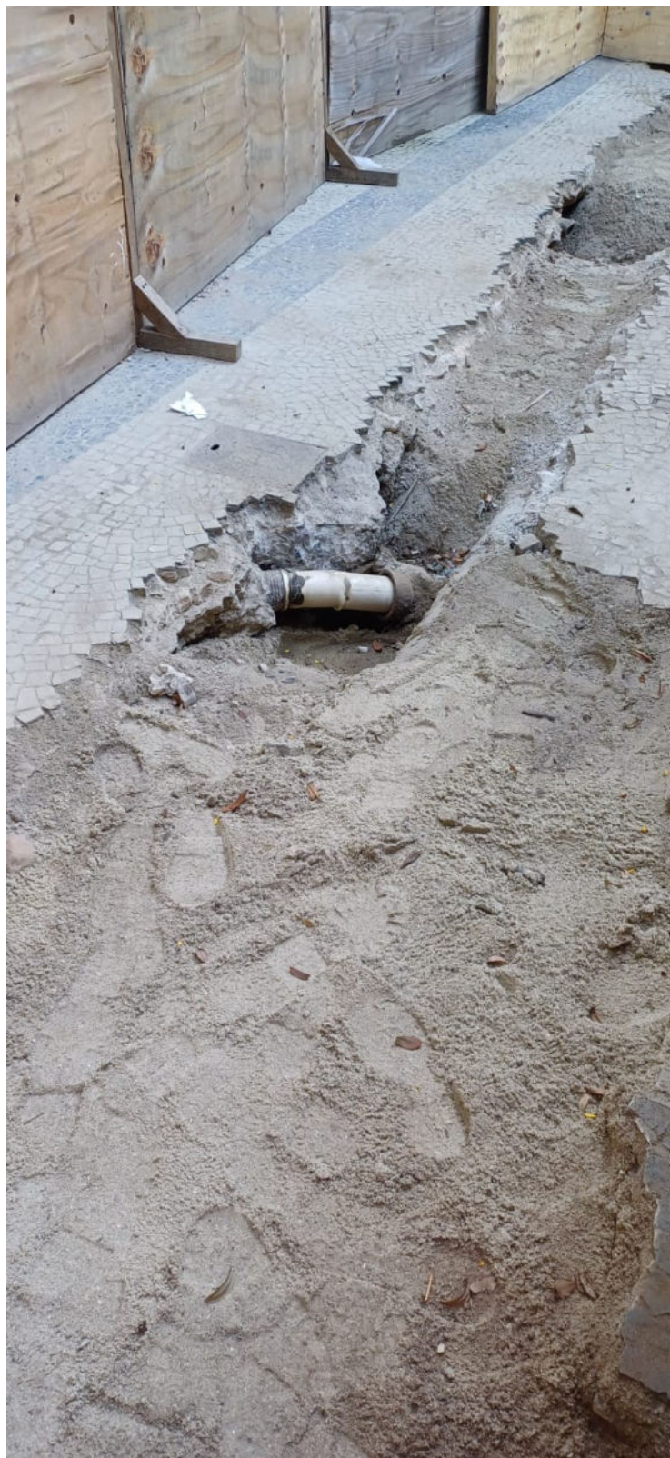
FOTO 05 – Detalhe de acoplamento efetuado no dreno das águas pluviais da cobertura do prédio número 310.
