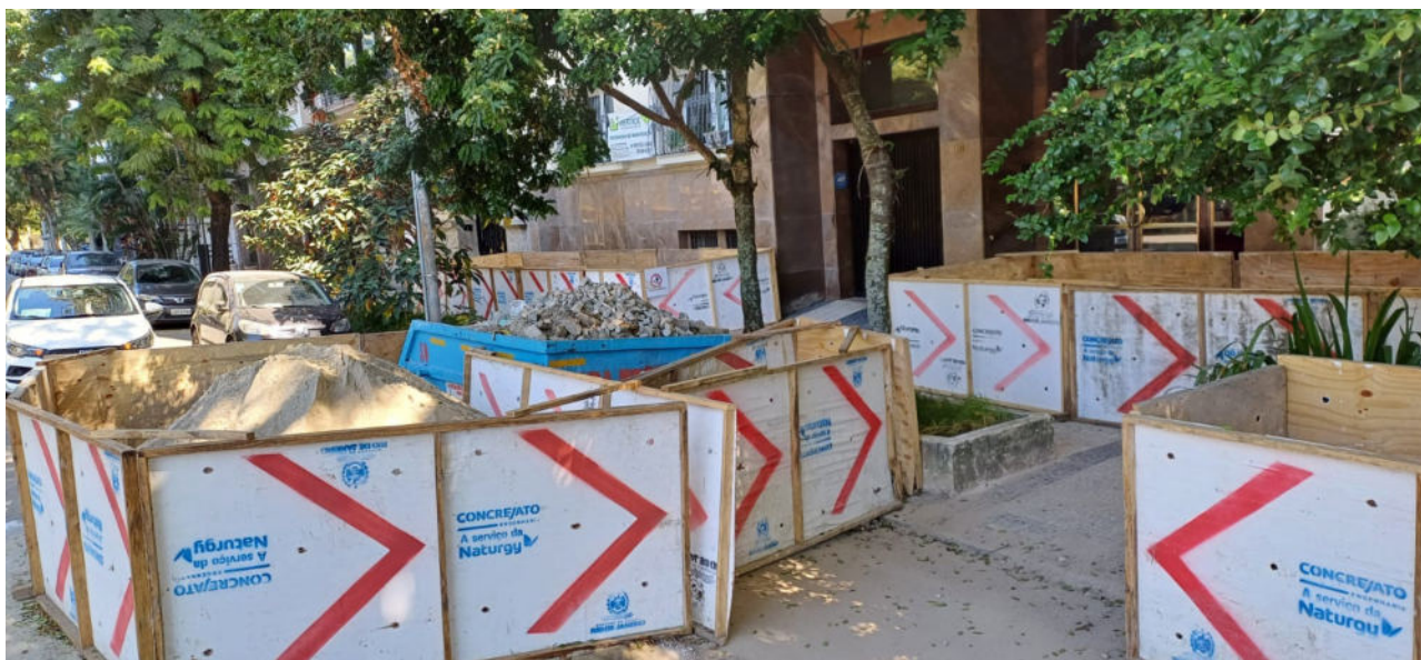
FOTO 02 – Vista da restrição de circulação em virtude da necessária interdição das calçadas.
