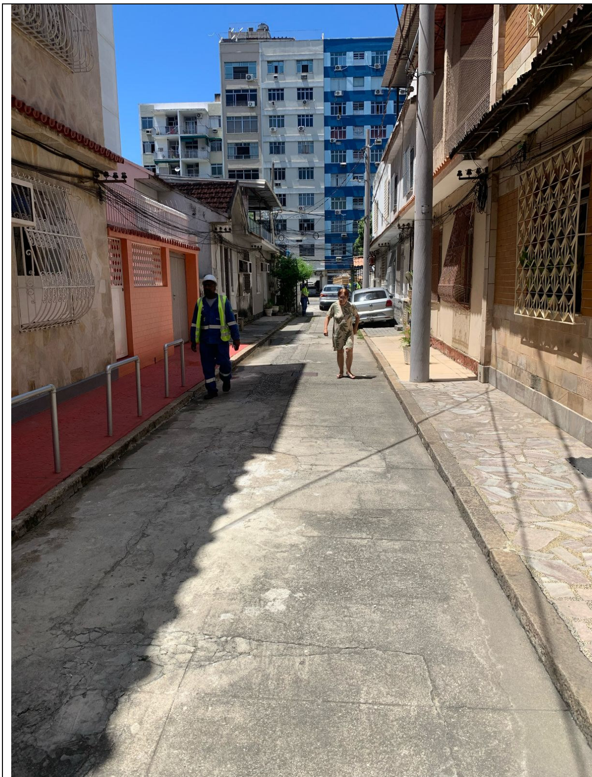
Foto 5: Trecho onde passa a tubulação de gás de 3 polegadas e onde será feita a renovação.
