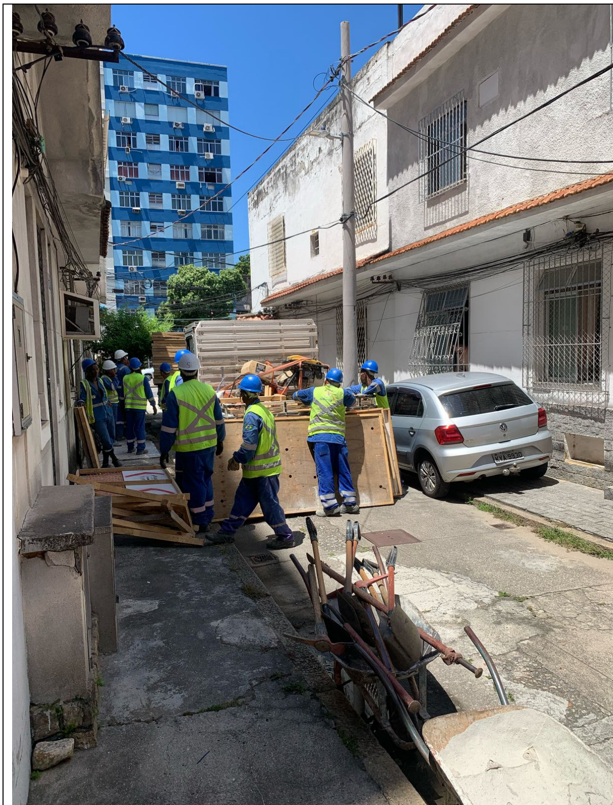
Foto 2: Funcionários da Braços se preparando para iniciar a obra.
