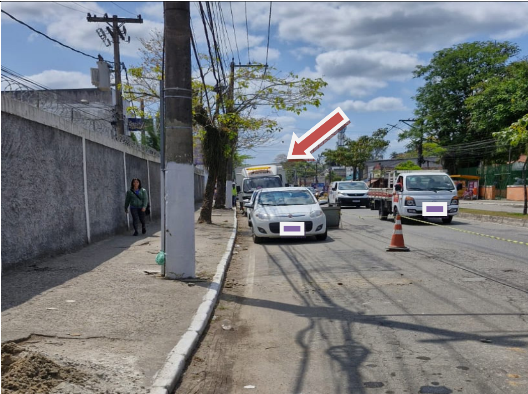
Foto 4: Desvios de trânsito anteriores ao incidente, caminhões e máquinas envolvidos na obra ao longo da rua no detalhe.
