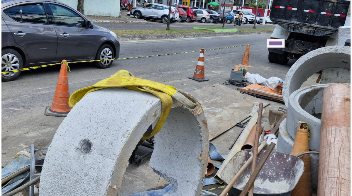
Foto 5: Isolamento, material e maquinário que estava sendo utilizado para a obra.
