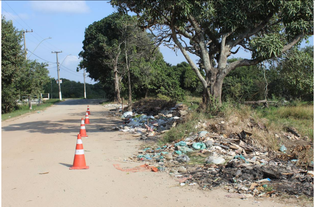
Foto 9: Cones de sinalização da obra.
