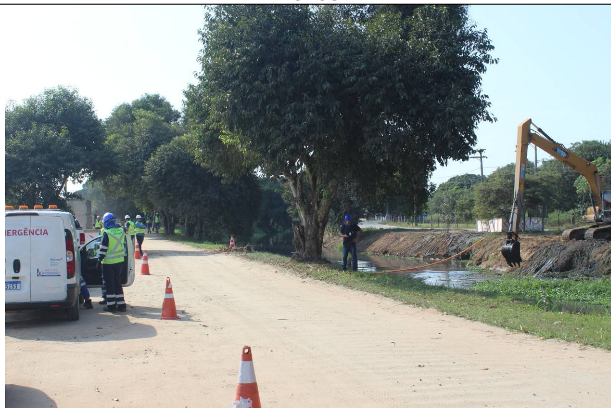
Foto 2: Cones de sinalização, uma retroescavadeira do INEA e trabalhadores da Naturgy ao fundo.
