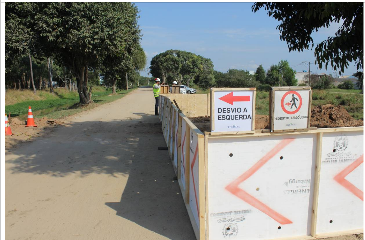
Foto 8: Obra de reconstrução do duto danificado e as placas de sinalização.
