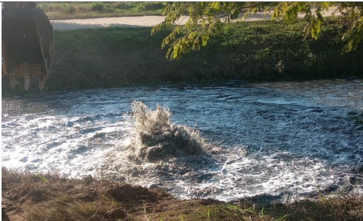
Foto 1: Foto do registro do acidente, com o gás vazando no canal.
