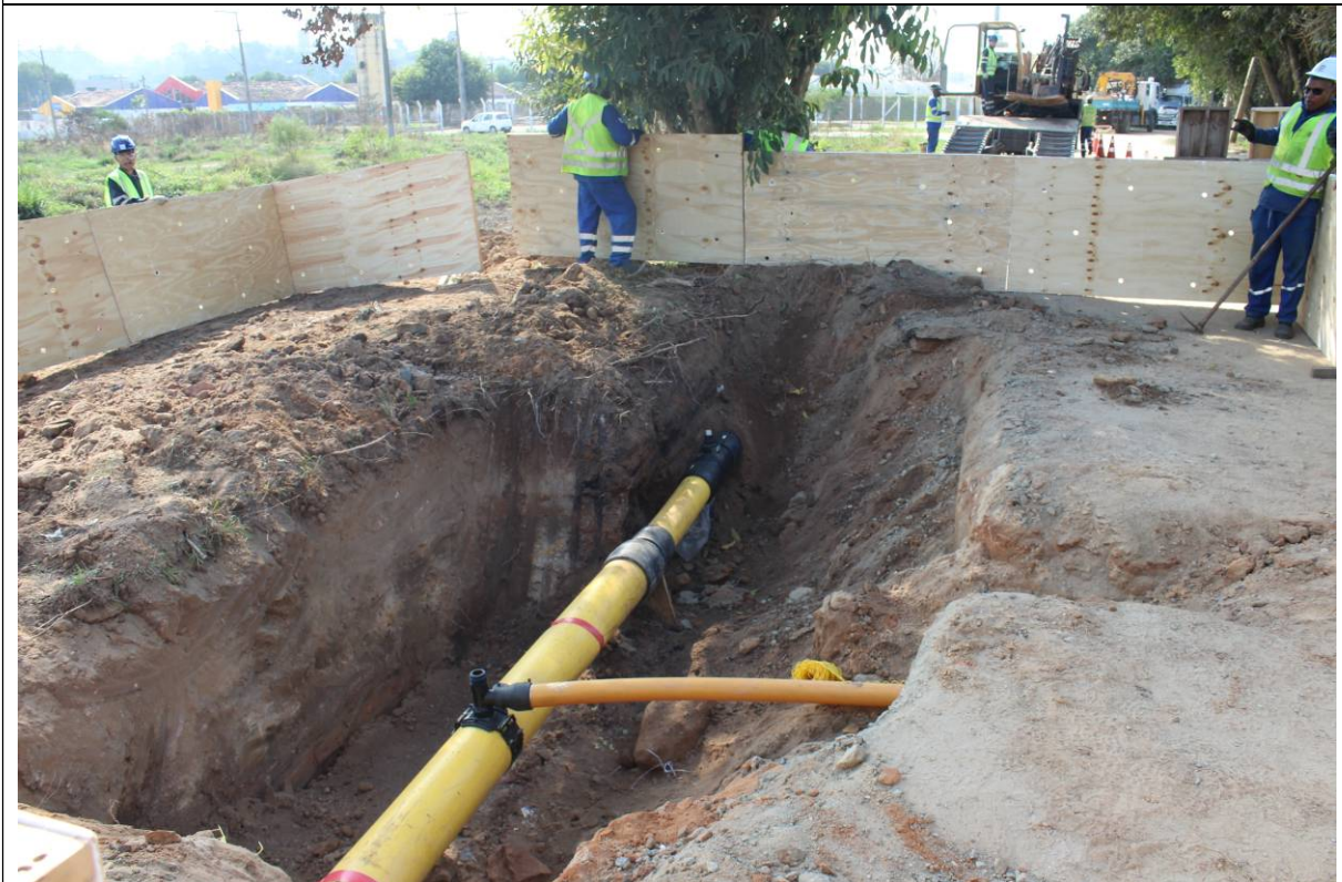
Foto 7: Bypass da Naturgy já instalado.
