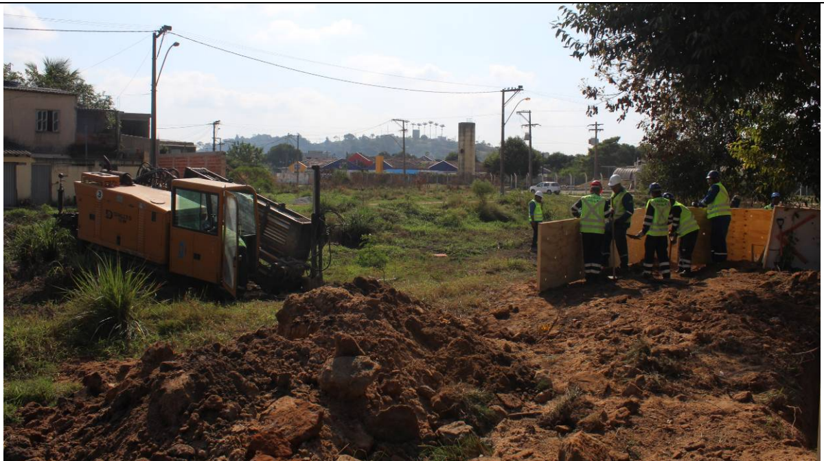
Foto 10: Máquina de perfuração direcionada da Naturgy.
