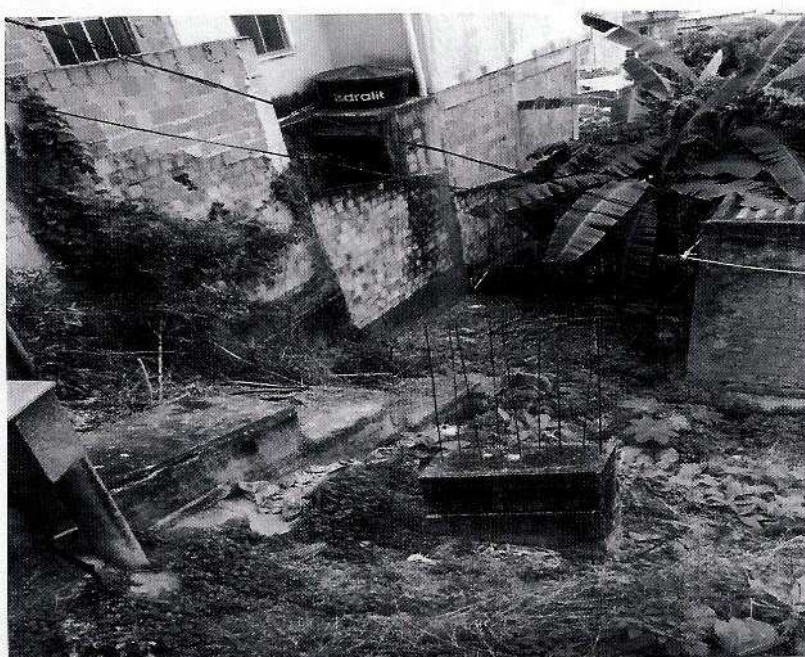
Coletor - Galeria de Águas Pluviais (fig 02)
