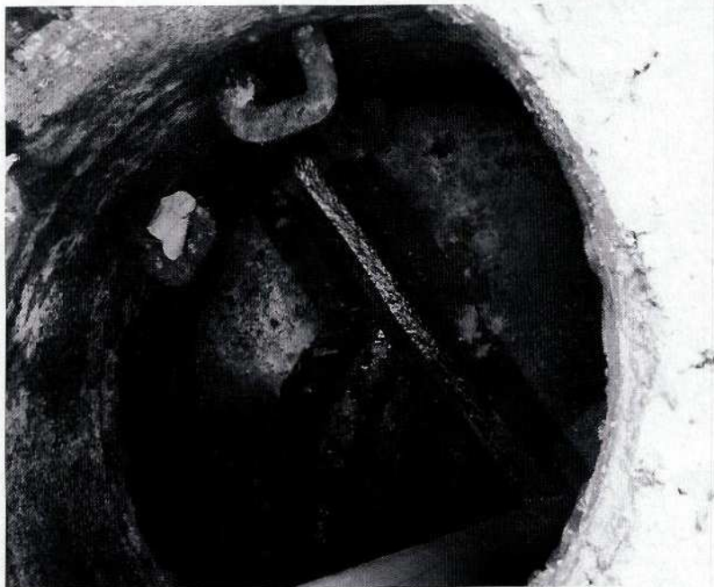
PV sem esgoto - Rua Capitão Aliatar Martins (fig 08)
