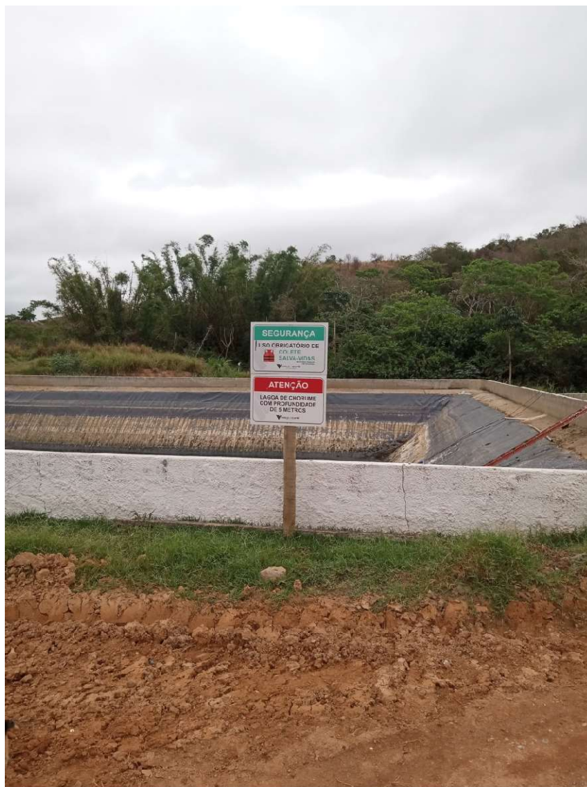
Figura 13: Lagoa de armazenamento de chorume passando por manutenção periódica para retirada de lodo
