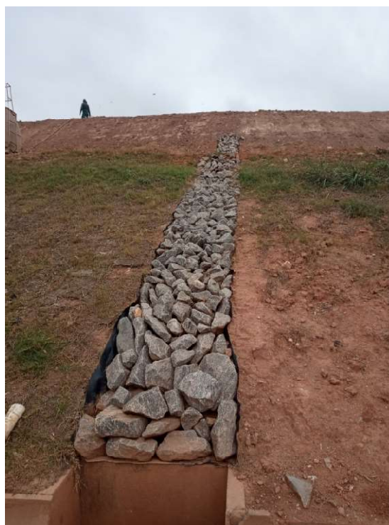
Figura 9: Detalhe do sistema de drenagem do talude
