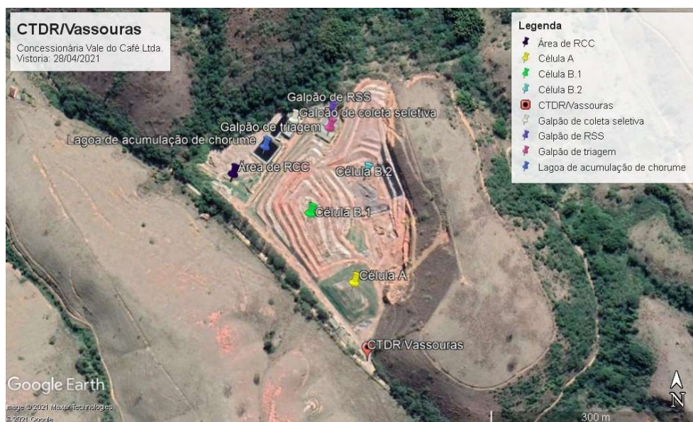
Figura 1: Vista aérea do CTDR/Vassouras. Fonte: Google Earth, 28/04/2021.
