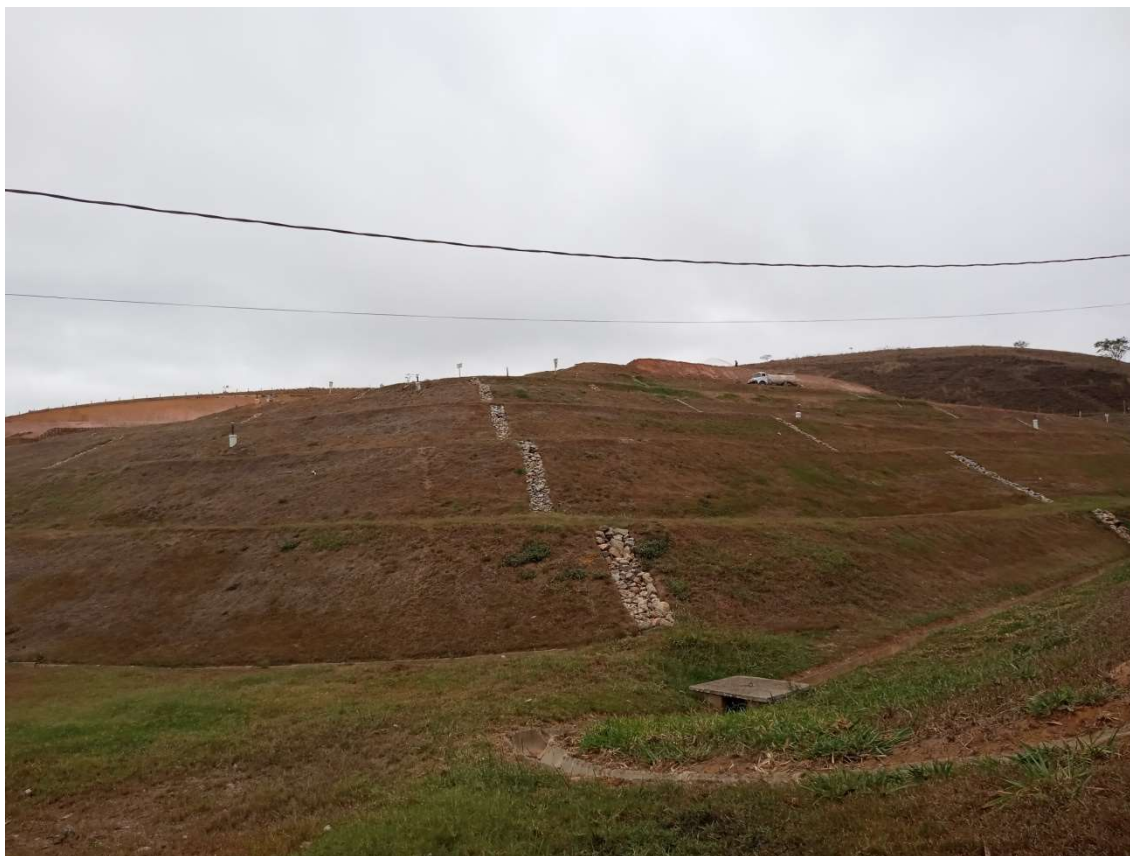
Figura 11: Cobertura vegetal do talude
