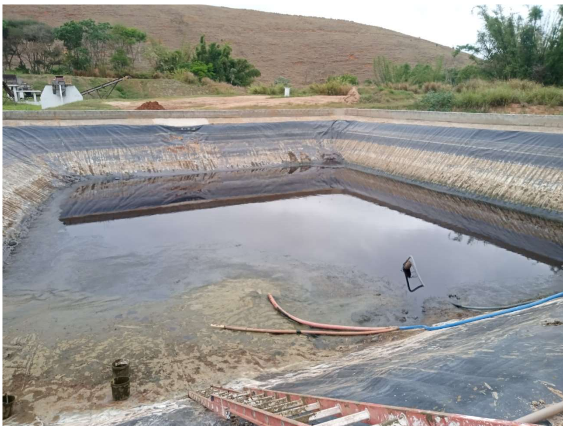
Figura 12: Lagoa de armazenamento de chorume passando por manutenção periódica para retirada de lodo
