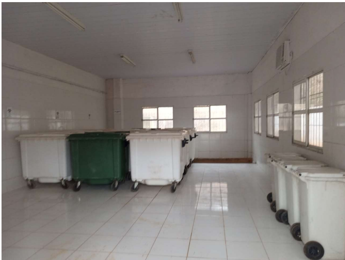
Figura 16: Abrigo temporário de RSS. Onde os resíduos são estocados até serem direcionados para a , empresa contratada para realizar a autoclavagem
