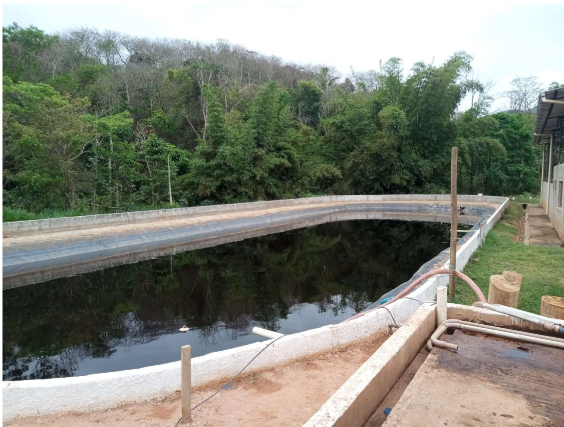
Figura 14: Lagoa de armazenamento de chorume
