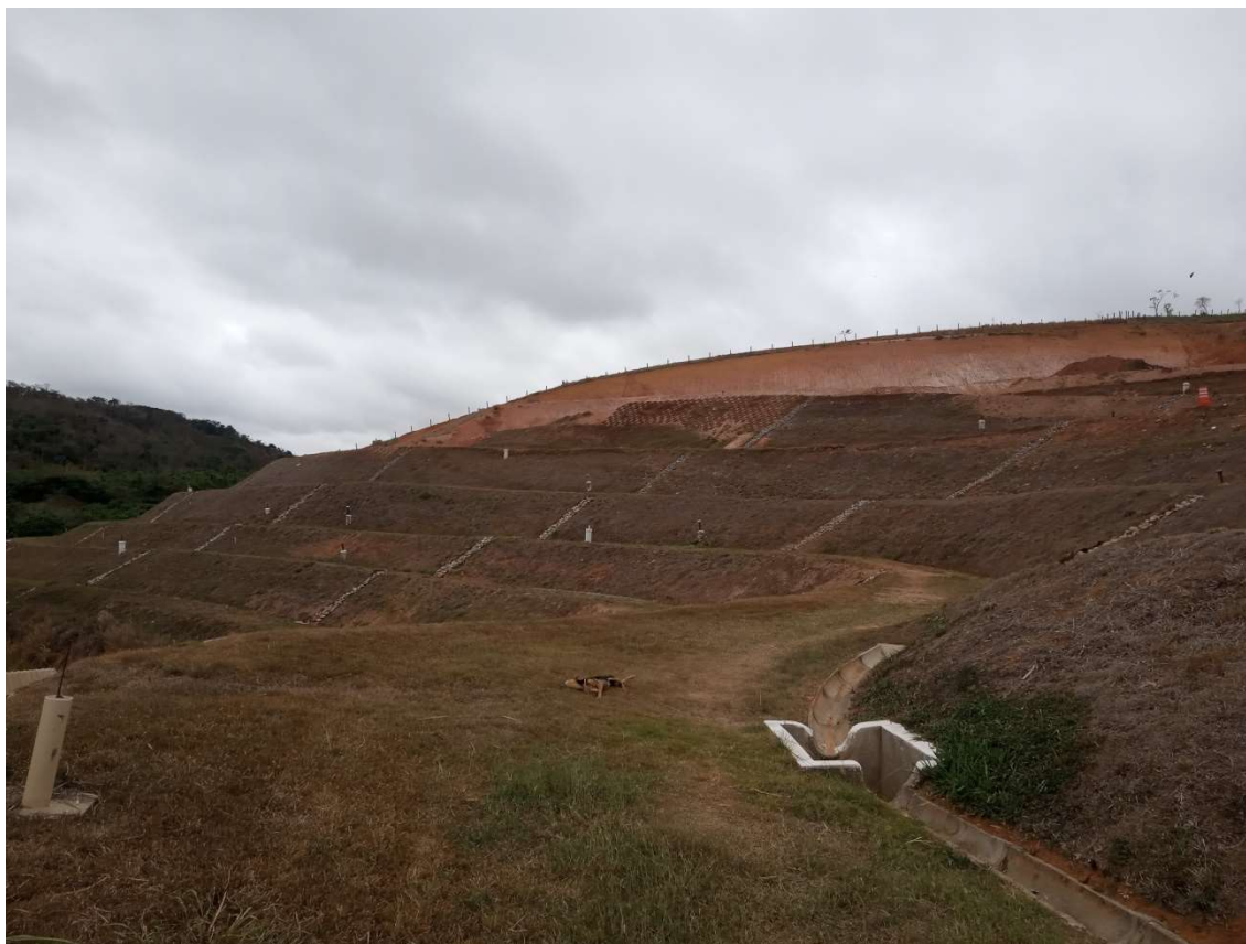
Figura 10: Cobertura vegetal do talude
