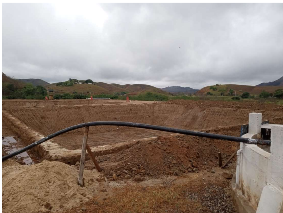
Figura 17 : Preparação das novas lagoas de recebimento de chorume
