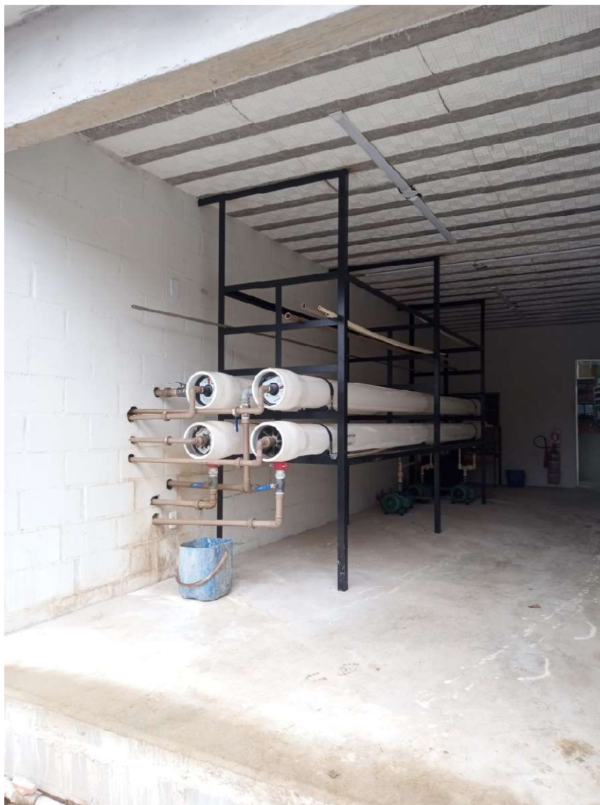
Figura 19: Novo local construído em alvenaria para a instalação e abrigo do equipamento de osmose reversa. Equipamento em operação.
