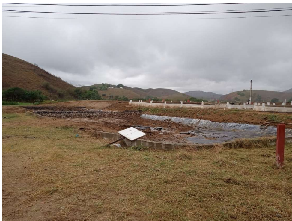
Figura 18 : Leito de secagem de lodo
