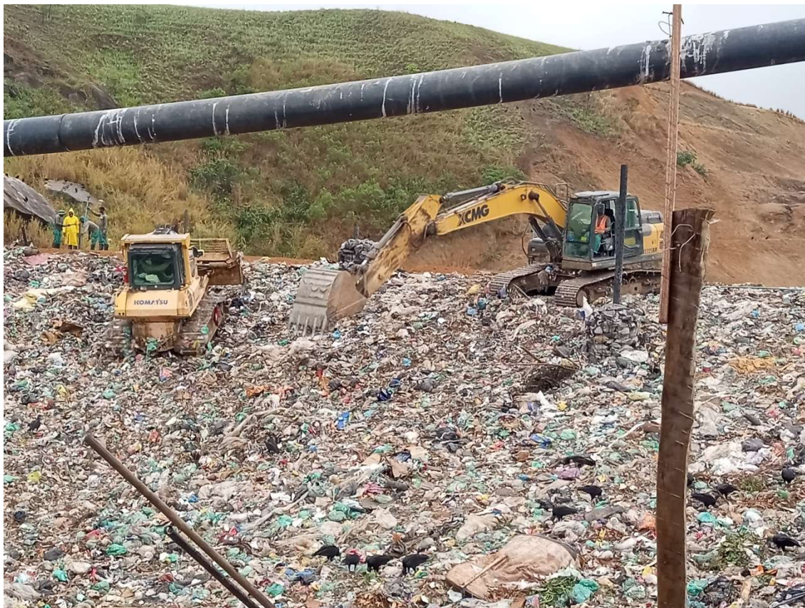
Figura 10: Frente de trabalho , compactação e cobertura do resíduo
