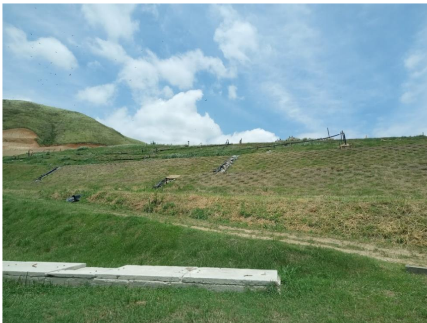
Figura 6: Taludes com vegetação recomposta
