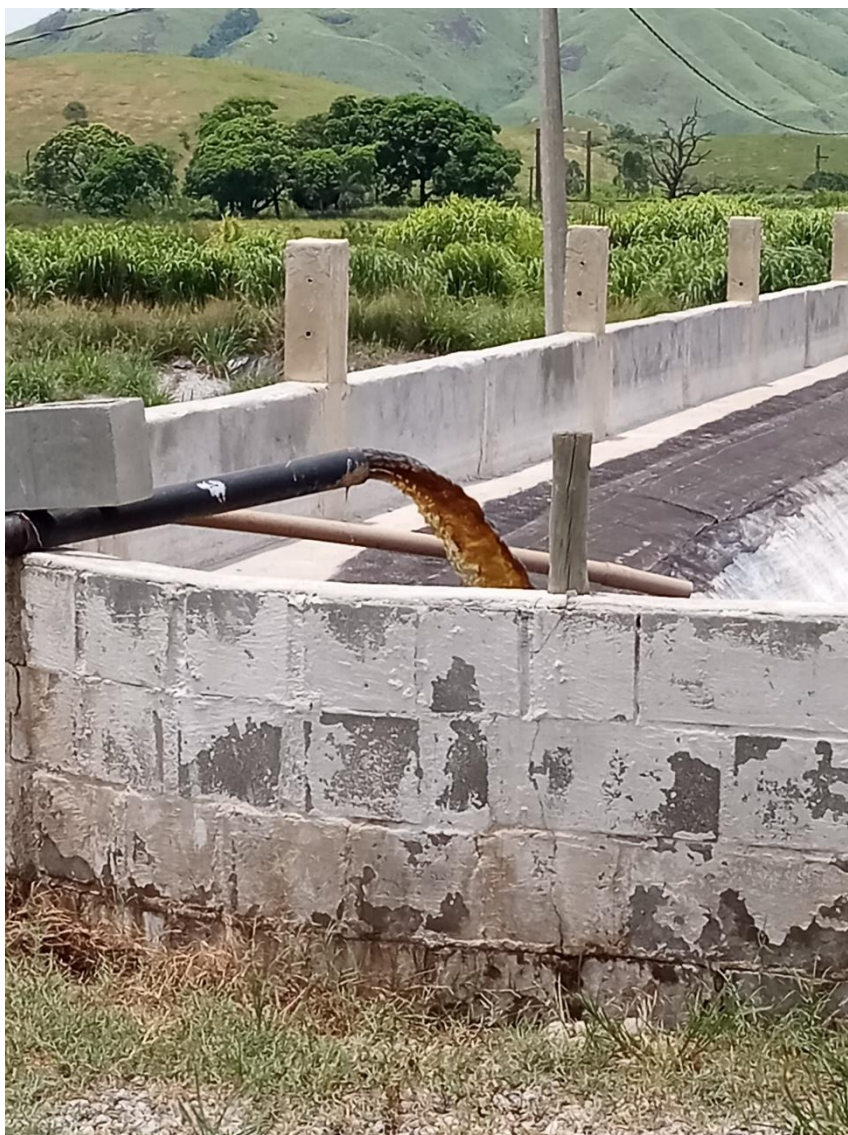
Figura 10: Lagoa de chorume , detalhe do fluxo do lixiviado
