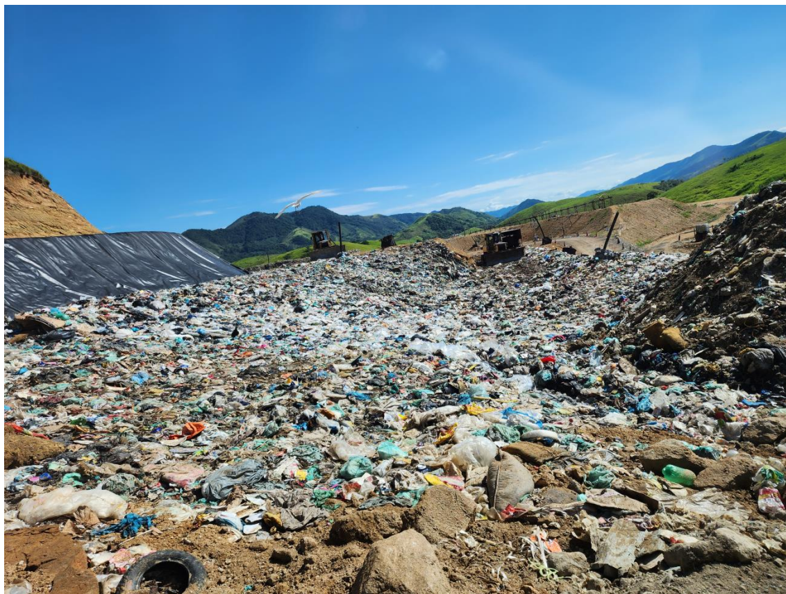
Figura 3: Frente de trabalho - Compactação e cobertura dos resíduos
