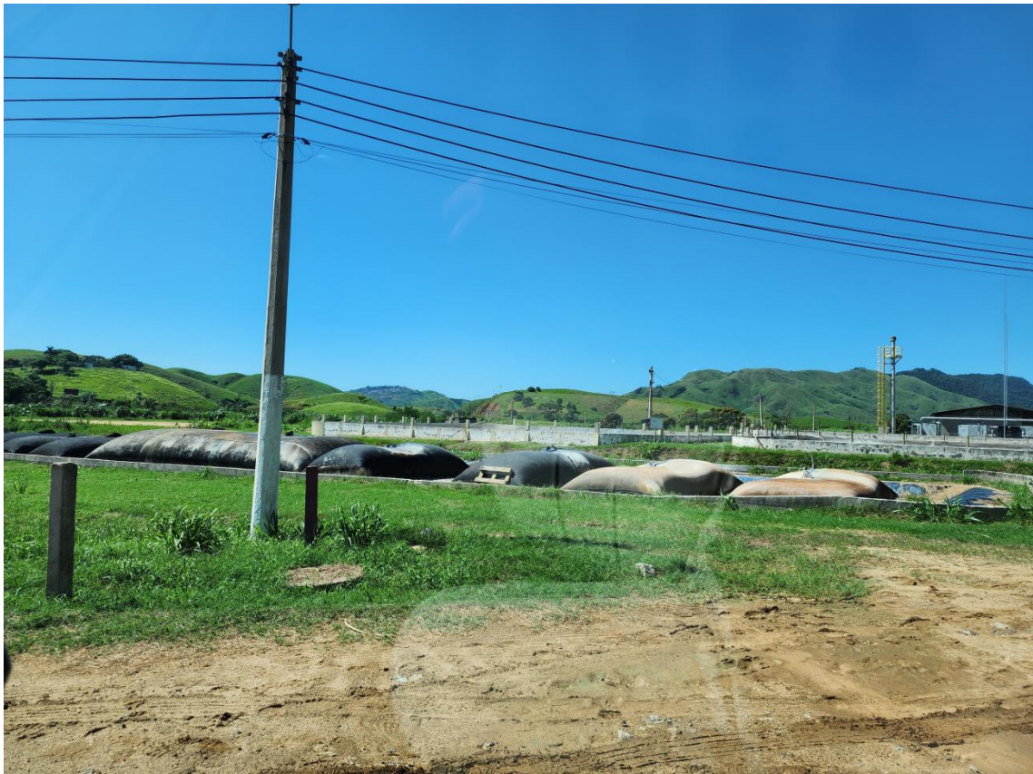
Figura 9: BAGS de armazenagem e secagem de lodo.
