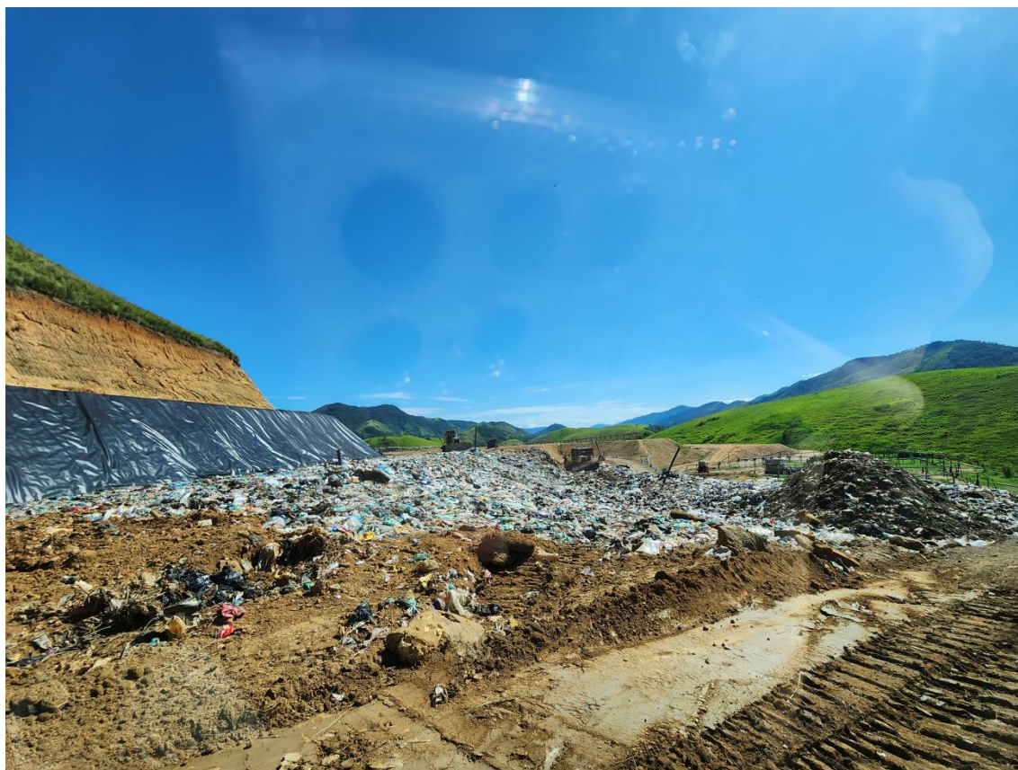
Figura 4: Frente de trabalho – Compactação e cobertura dos resíduos
