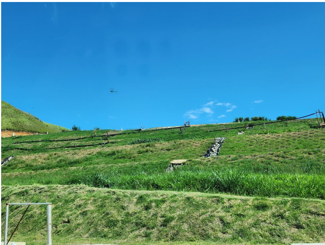
Figura 5: Vegetação do talude recomposta
