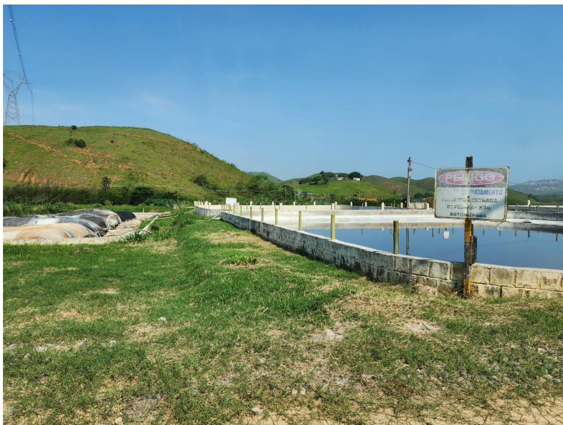
Figura 11: BAGS de armazenagem e secagem de lodo.
