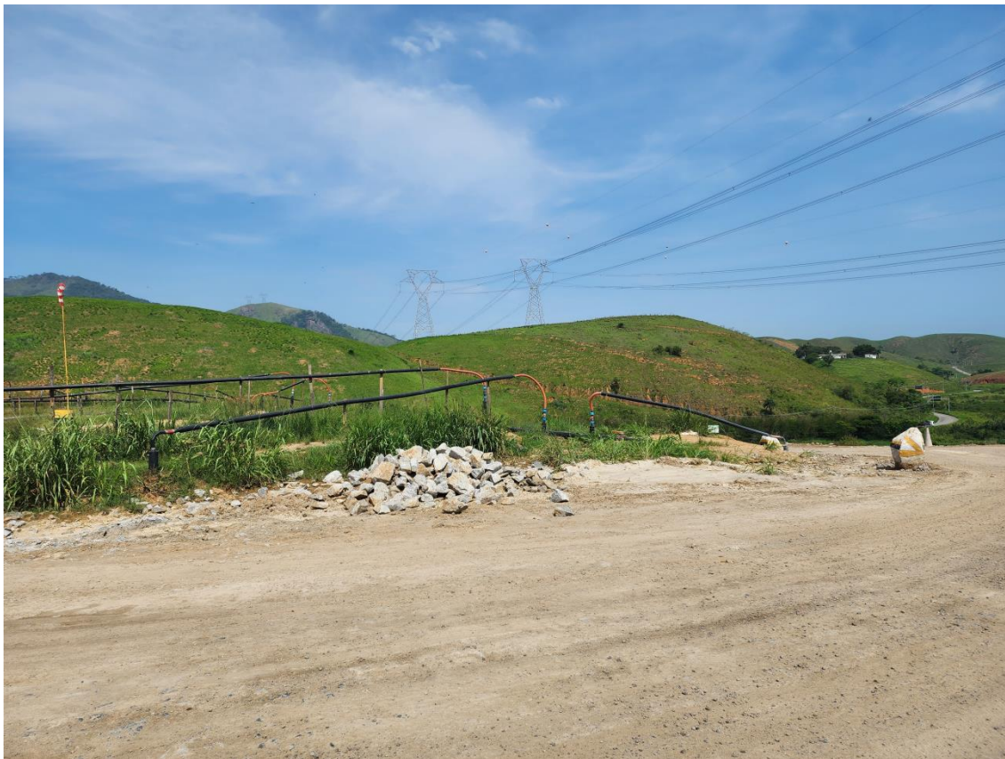
Figura 5: Dutos de captação de gases.
