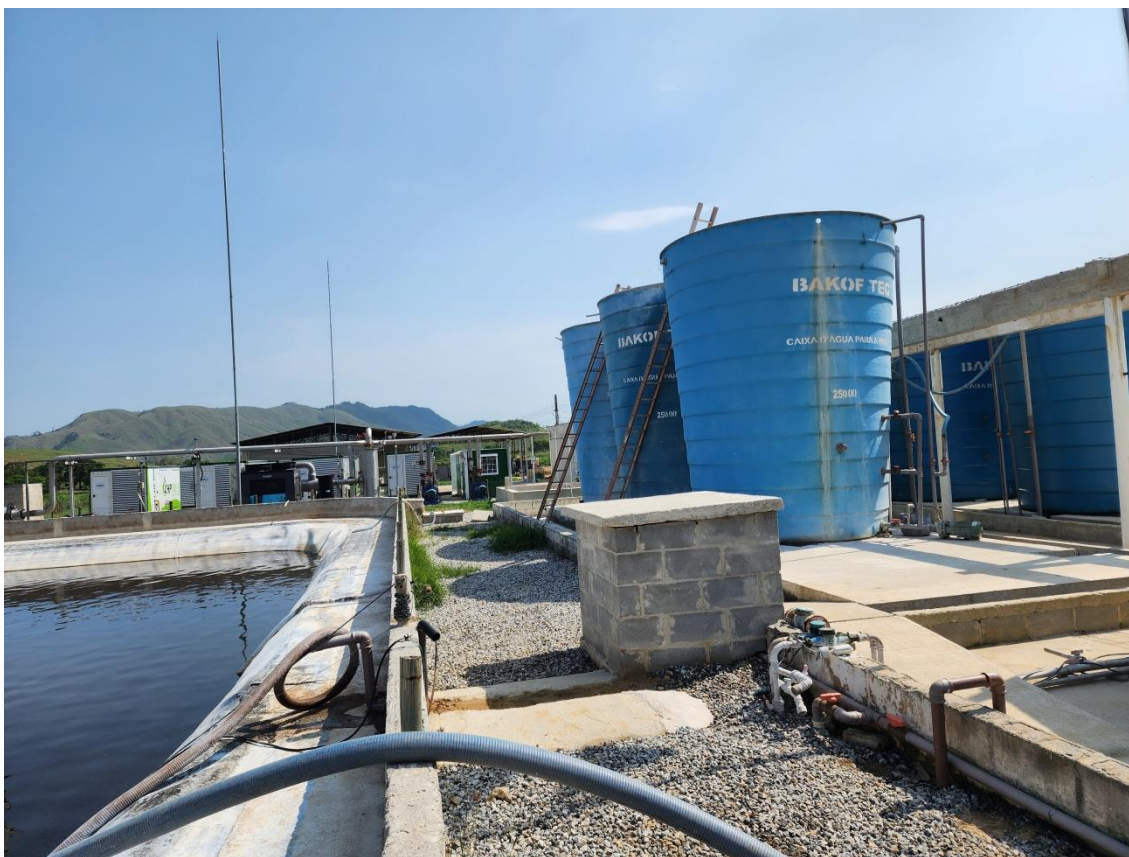
Figura 13: Ampliação e melhorias do local de assentamento dos tanques de água pós tratamento .
