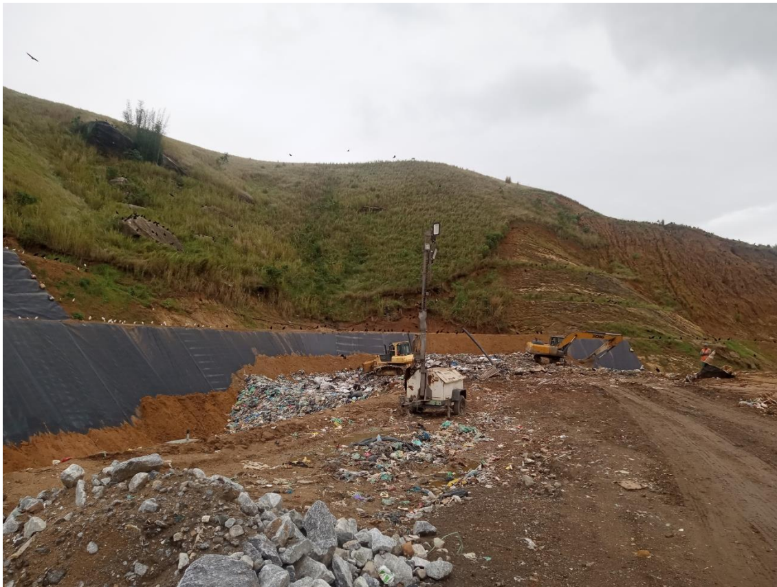
Figura 5: Frente de trabalho – Cobertura dos Resíduos e ao fundo a Geomembrana
