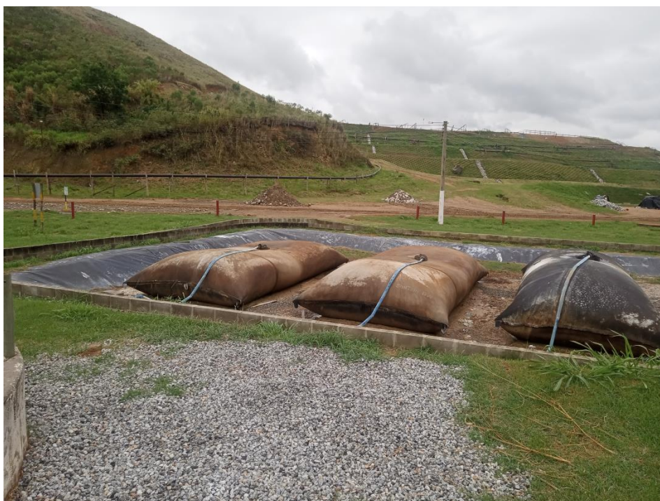
Figura 15: BAGS de armazenagem e secagem de lodo.
