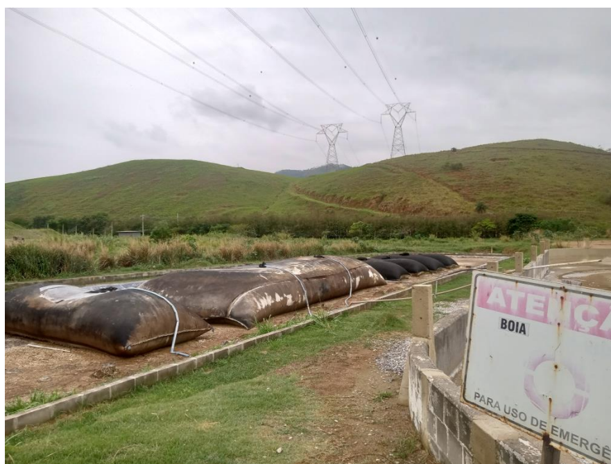
Figura 16: BAGS de armazenagem e secagem
