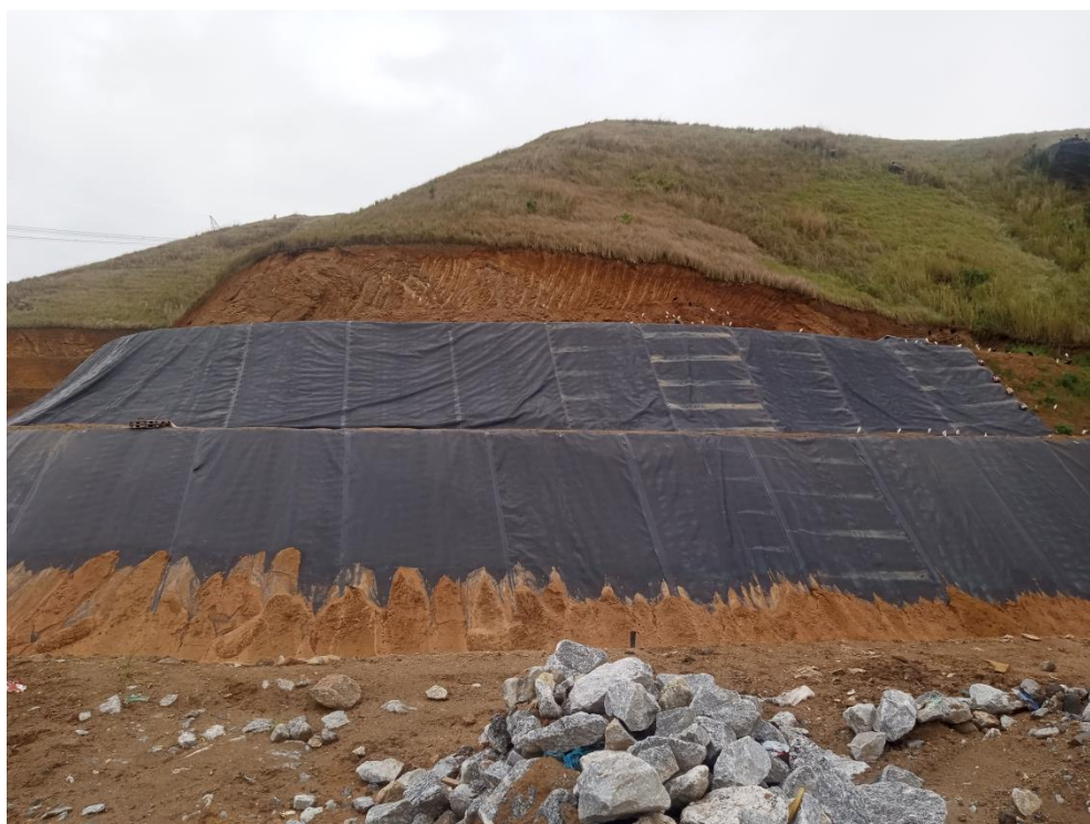
Figura 6: Detalhe , aplicação da Geomembrana
