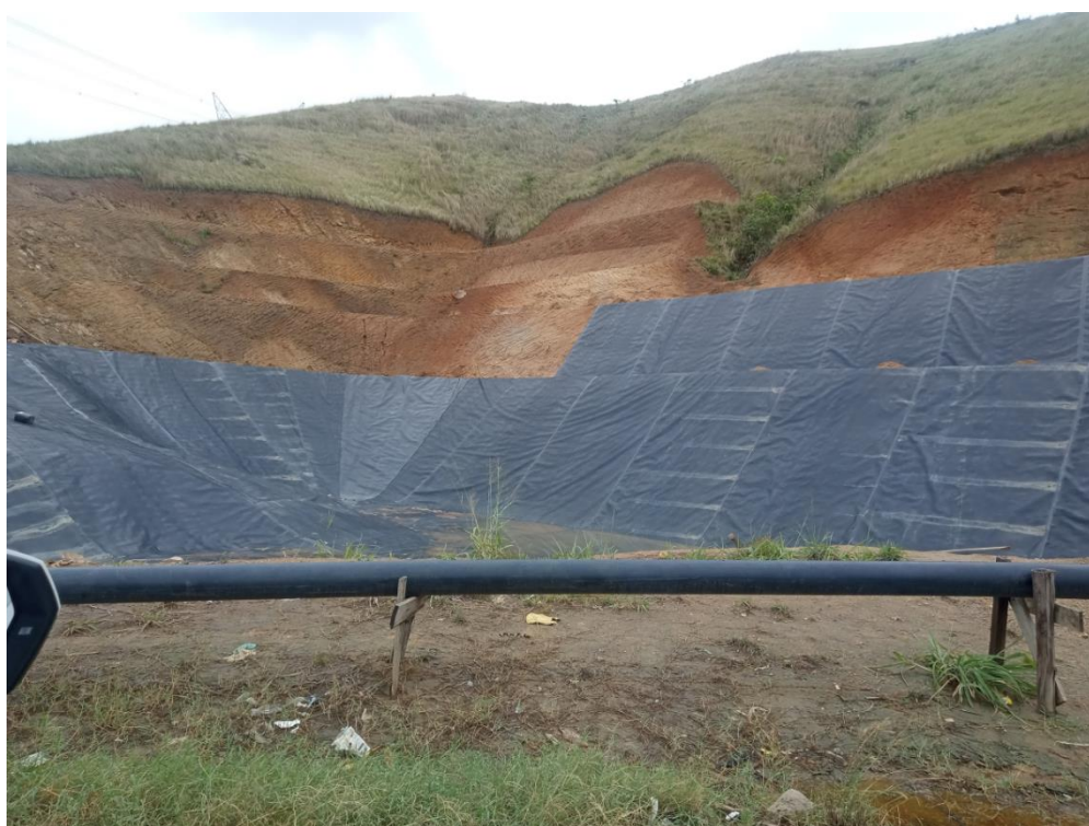
Figura 7: Detalhe , aplicação da Geomembrana
