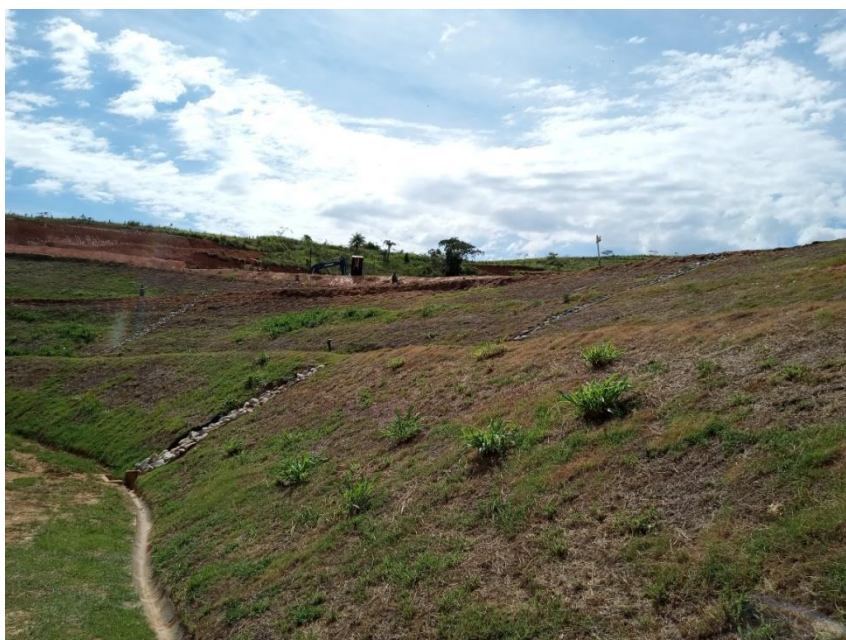
Figura 12: Cobertura vegetal e Drenagem do talude
