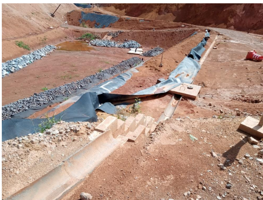
Figura 6: Preparação da nova célula . Detalhe da drenagem e Geomembrana
