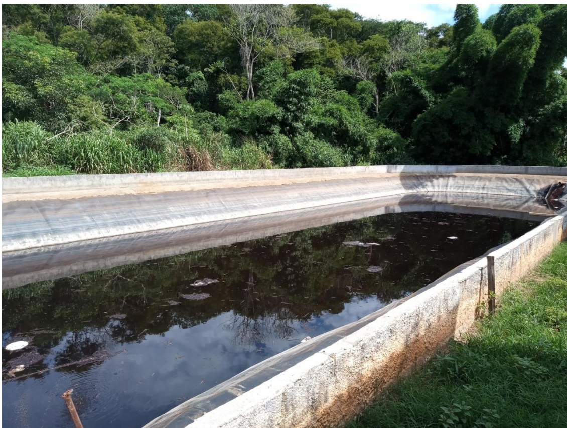
Figura 5: Lagoa de recebimento e armazenagem de chorume
