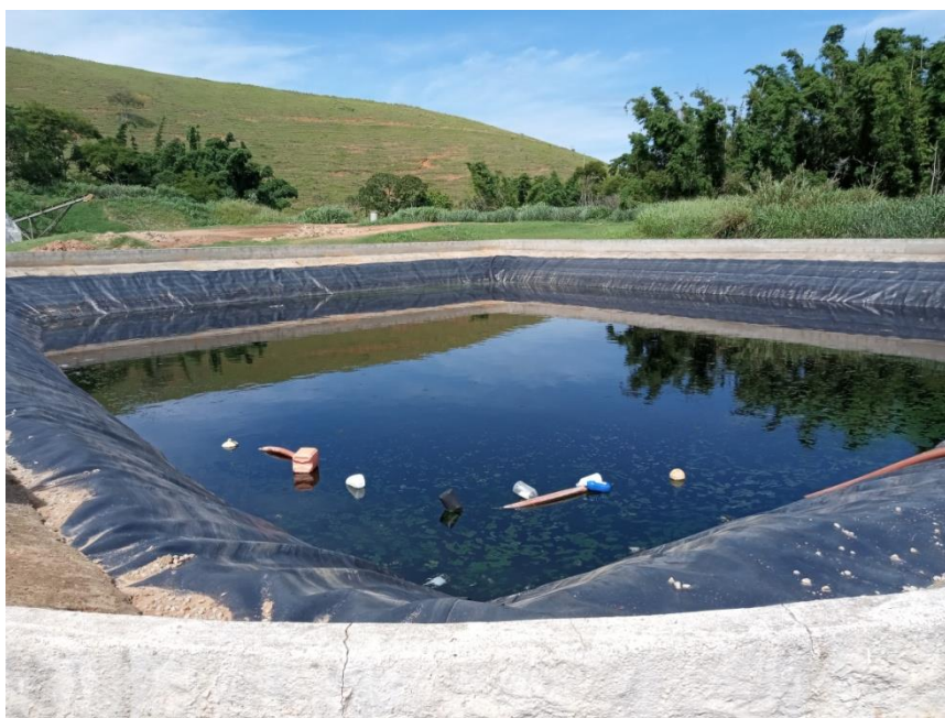
Figura 6: Lagoa de recebimento e armazenagem de chorume
