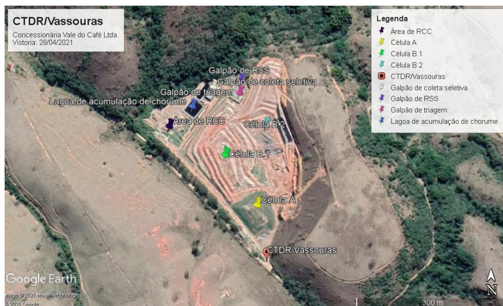
Figura 1: Vista aérea do CTDR/Vassouras. Fonte: Google Earth, 28/04/2021.
