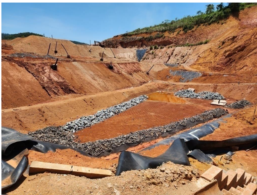
Figura 8: Vista da área a ser utilizada, conforme a Concessionária, para a remediação da célula a
