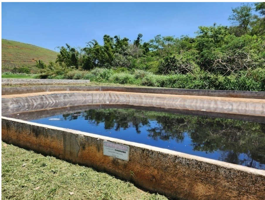
Figura 15: Lagoa de recebimento e armazenagem de chorume
