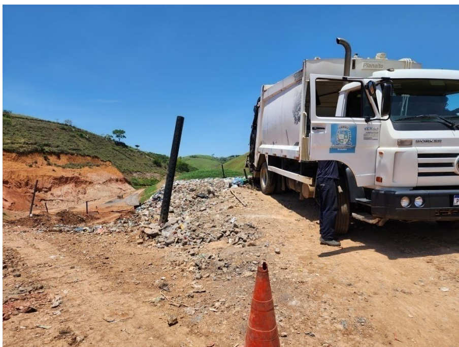
Figura 13: Vista de caminhão fazendo a descarga na frente de trabalho
