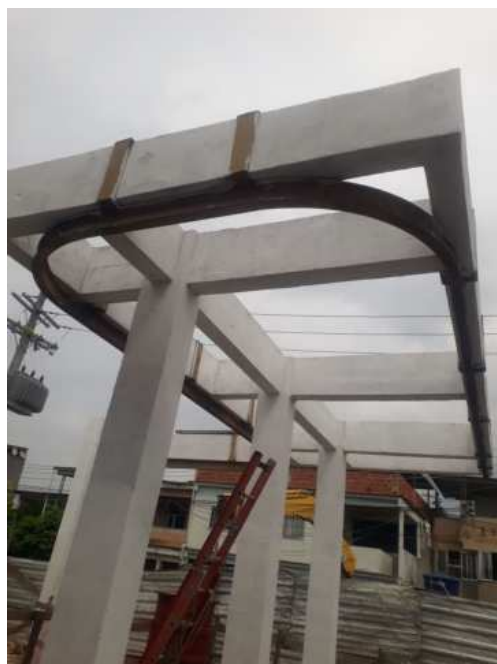
Foto 20 - Instalação das Monovias
