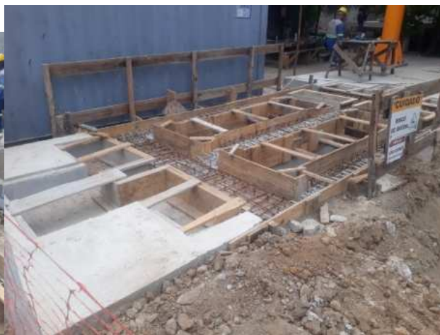
Foto 12 - Canal de Grades
