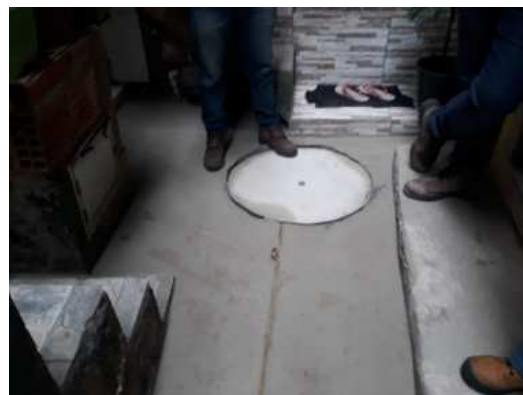
Foto 6: Pavimentação inicial pronta
