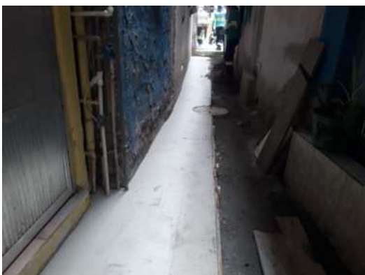
Foto 2: Pavimentação em andamento
