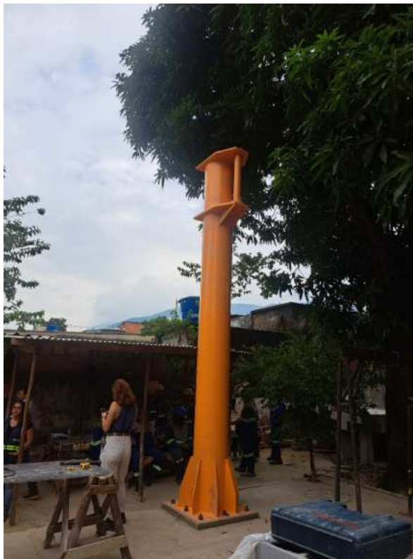
Foto 13 - Montagem do Guindaste
