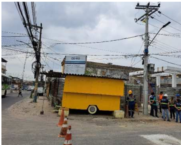
Foto 17 - Fachada da Obra EE Edson Passos
