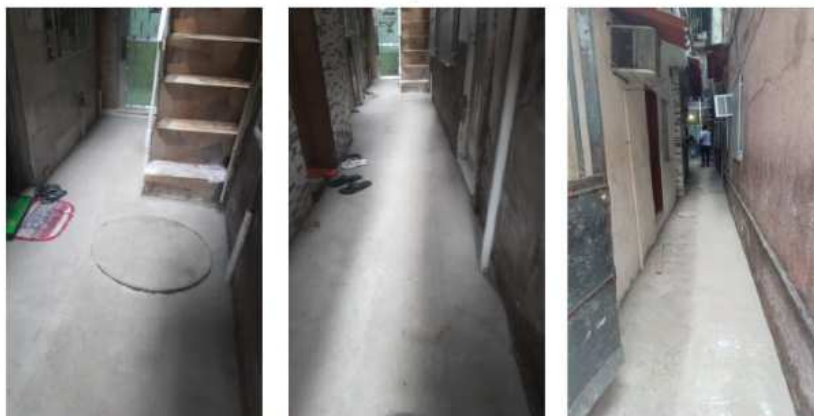
Figura 4: Serviço de repavimentação
