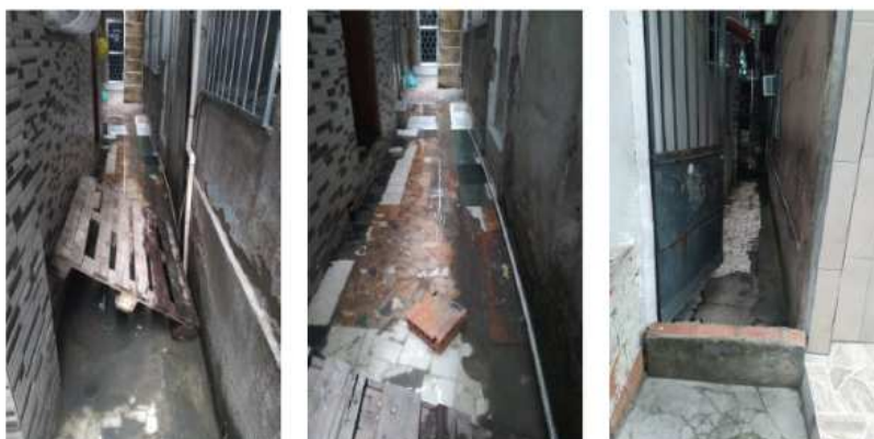
Figura 2: Esgoto in natura extravasando.
