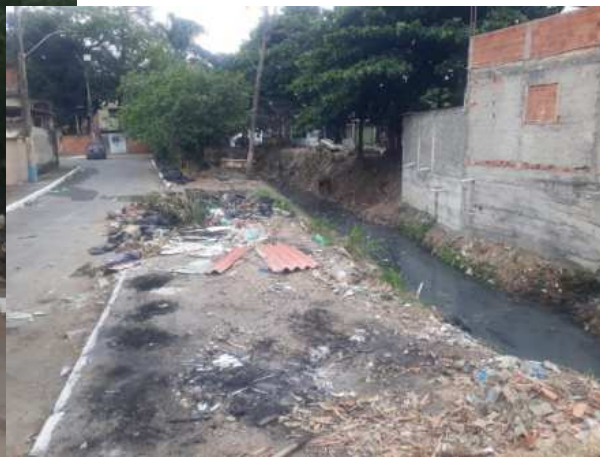
Foto 11 - Rio Socorro - Local da Captação
