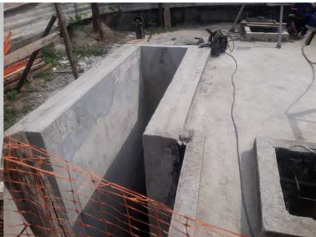
Foto 23 - Execução do CTS
