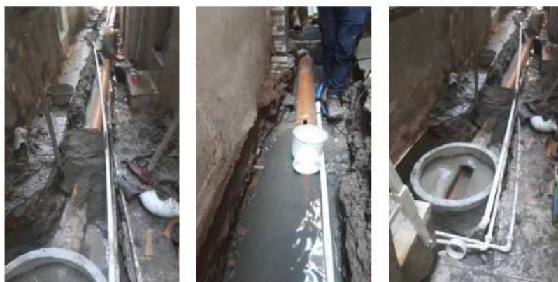
Figura 3: Assentamento de rede de esgoto tubos DN150 e remanejamento de ligações de água.
