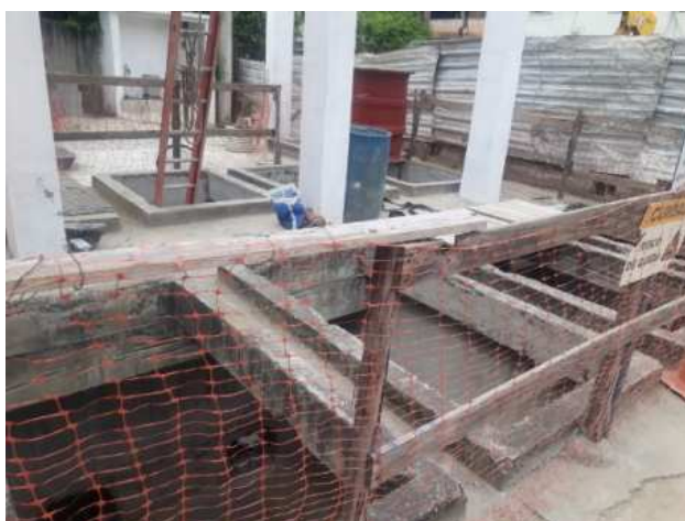
Foto 22 - Poço das Bombas
