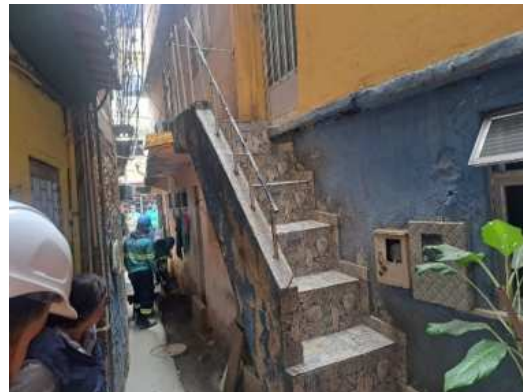
Foto 4: Execução da Pavimentação
