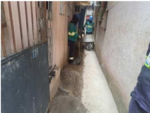
Foto 1: Beco 196 – Rua João Araújo
