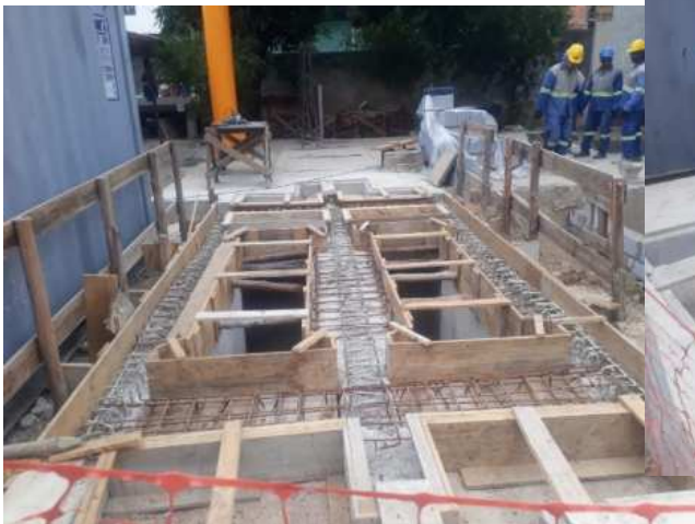
Foto 10 - Construção do CTS
