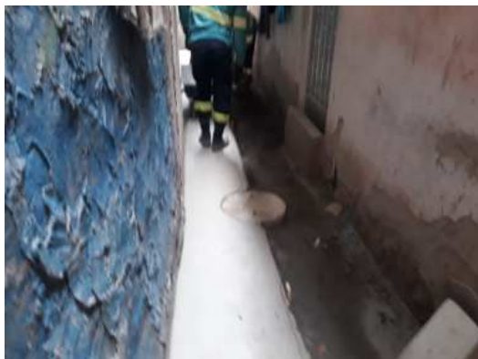
Foto 7: Execução da Pavimentação
