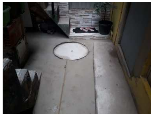
Foto 8: Poço de Visita - PV 1
