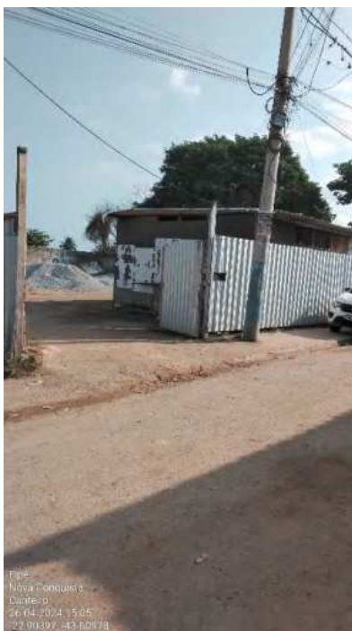
Foto 64 - Canteiro de Obras
