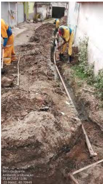
Foto 39 - Alinhando a Tubulação
