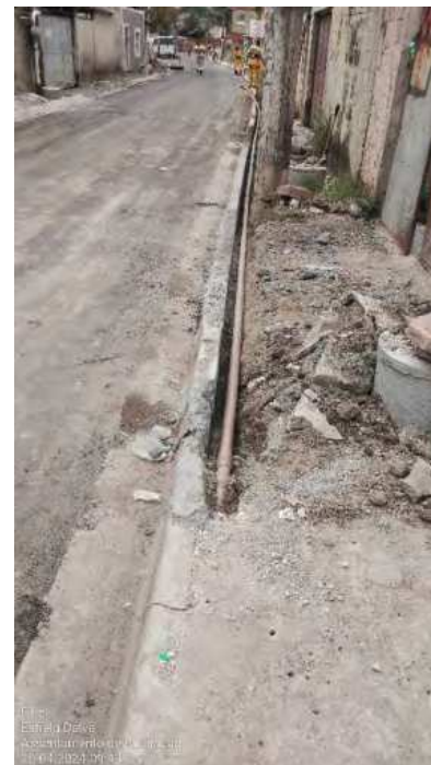
Foto 27 - Assentamento de Tubulação
