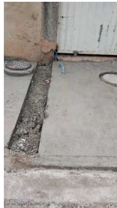
Foto 59 - PEAD de 20 mm
