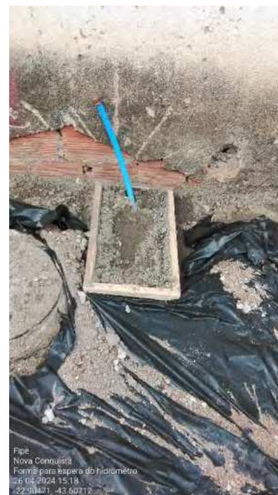
Foto 65 - Forma para espera do hidrômetro
