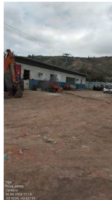
Foto 63 - Canteiro de obra
