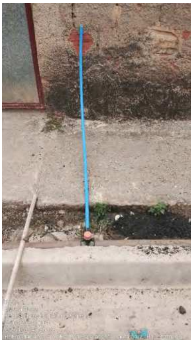
Foto 36 - TE de Serviço e PEAD de 20 mm
