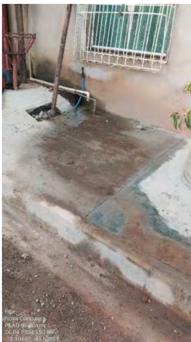
Foto 68 - PEAD de 20 mm
