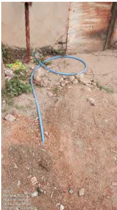
Foto 58 - PEAD de 20 mm
