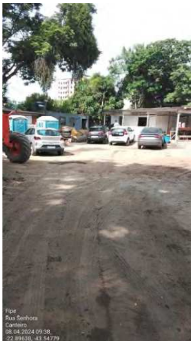
Foto 13 - Canteiro de Obras
