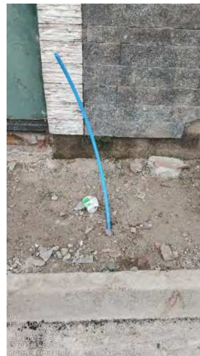
Foto 35 - TE de Serviço aflorado
