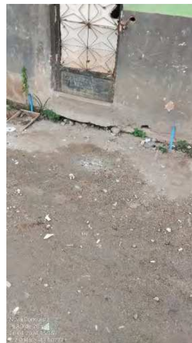
Foto 67 - PEAD de 20 mm
