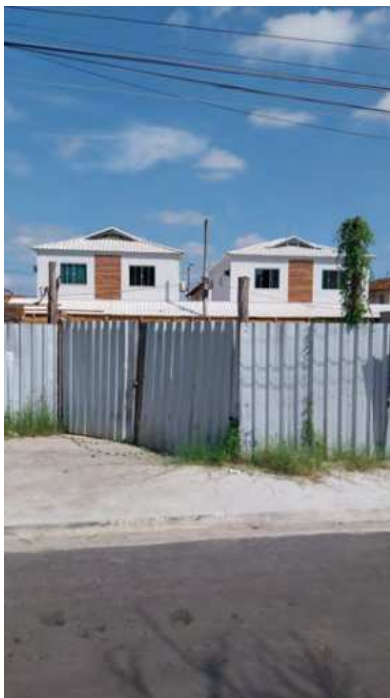
Foto 18 - Canteiro de Obra (desativado)
