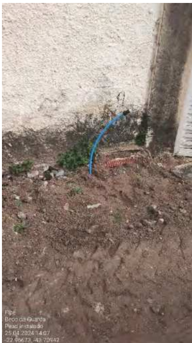
Foto 47 - PEAD instalado
