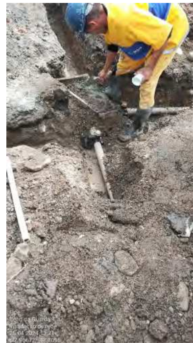
Foto 44 - Instalação de rede
