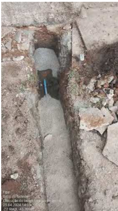
Foto 43 - Execução do berço com pó de pedra
