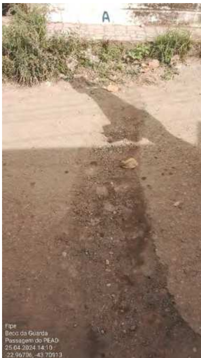
Foto 45 - Passagem do PEAD
