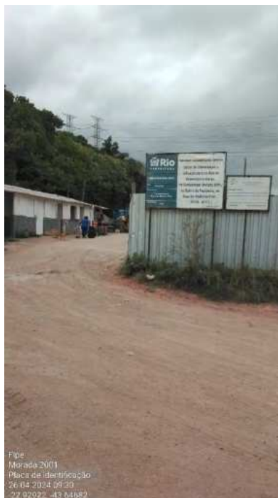
Foto 56 - Placa de Obras
