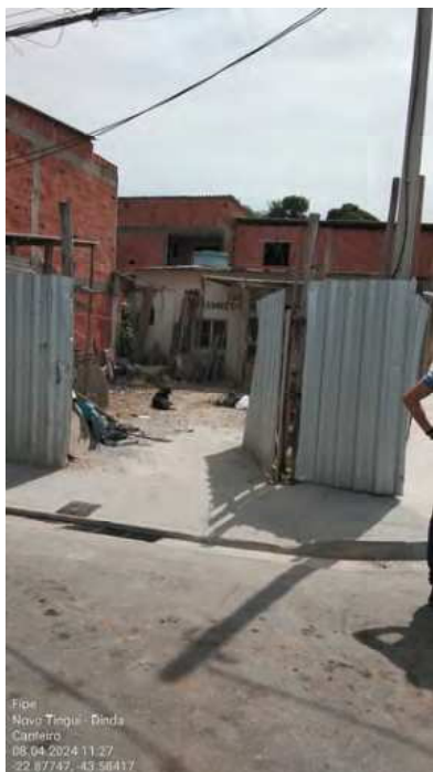
Foto 1 - Canteiro de Obra
