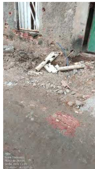
Foto 71 - PEAD de 20 mm
