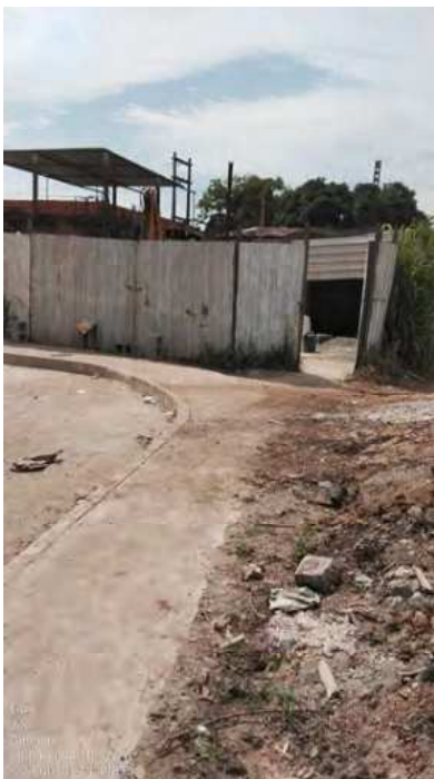
Figura 15 - Canteiro de Obra
