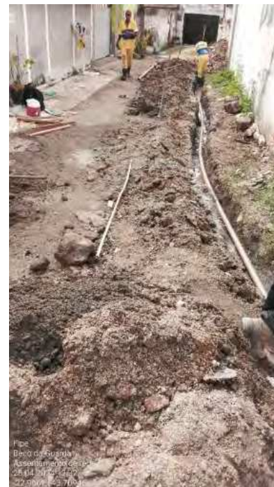
Foto 40 - Assentamento de rede
