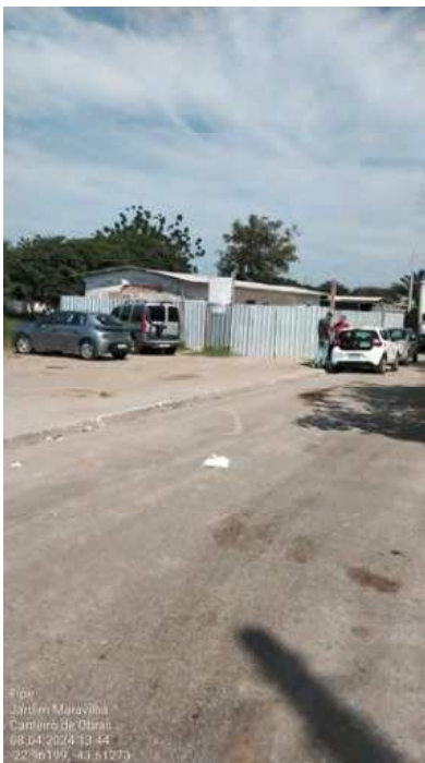
Foto 7 – Canteiro de Obra
