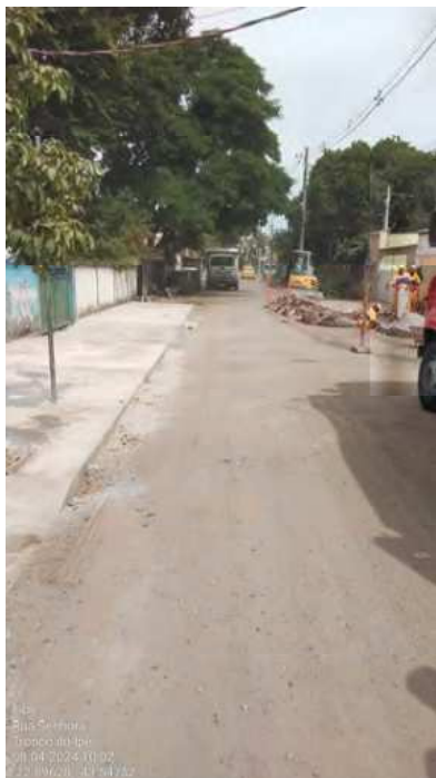
Foto 17 - Rua Tronco do Ipê
