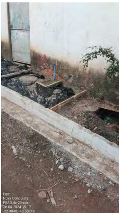
Foto 70 - PEAD de 20 mm
