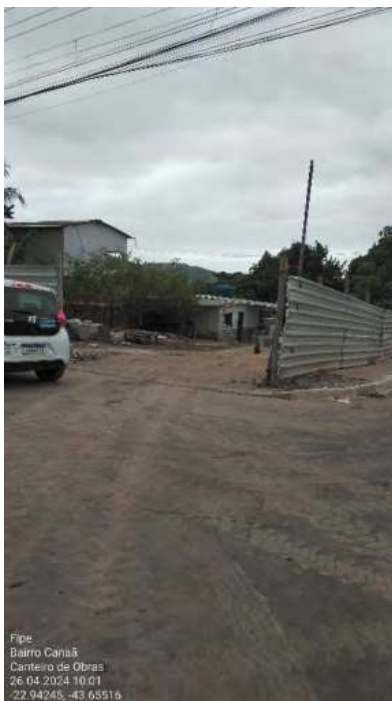
Foto 50 - Canteiro de Obras
