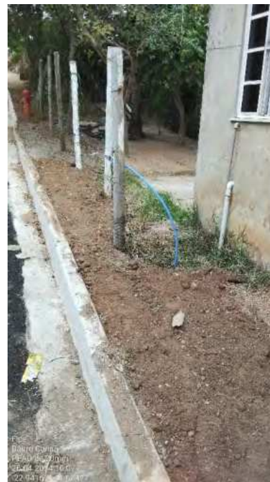
Foto 53 - PEAD de 20 mm
