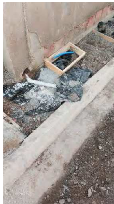
Foto 69 - PEAD de 20 mm
