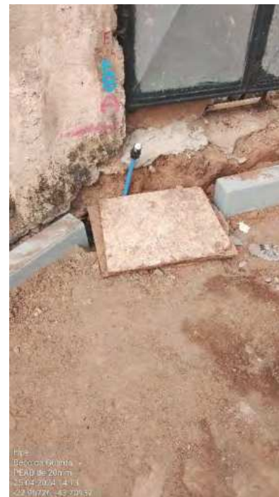
Foto 46 - PEAD de 20 mm
