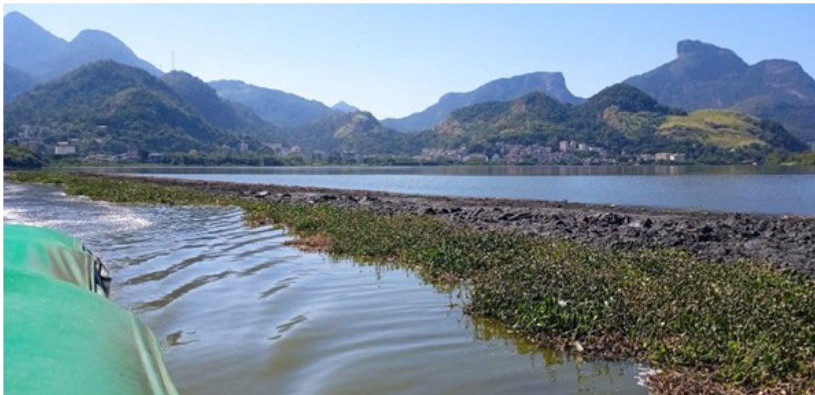
Foto 6 - Barreira formada com o lodo retirado do fundo da lagoa
