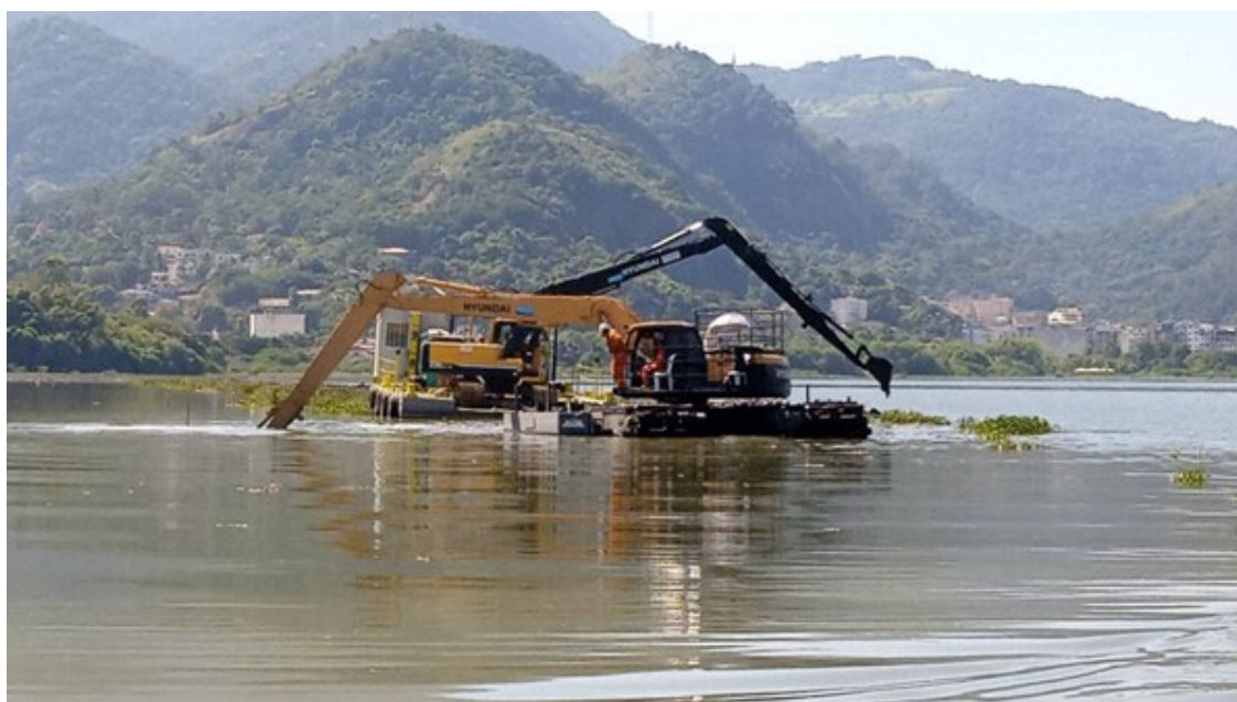
Foto 5 - Duas escavadeiras trabalhando em conjunto na dragagem de serviço
