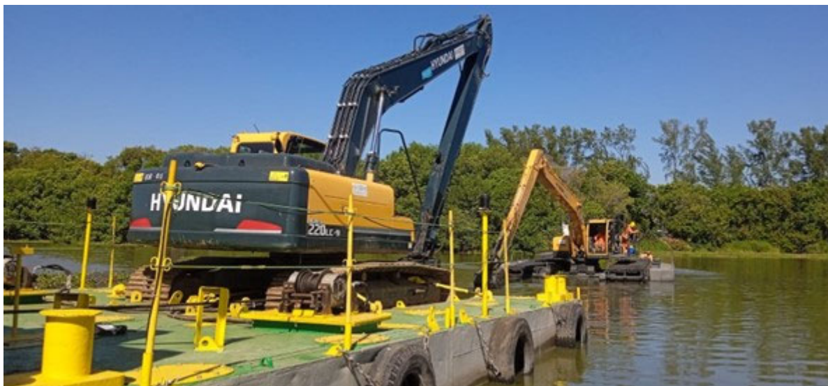
Foto 9 - Escavadeira sobre plataforma flutuante
