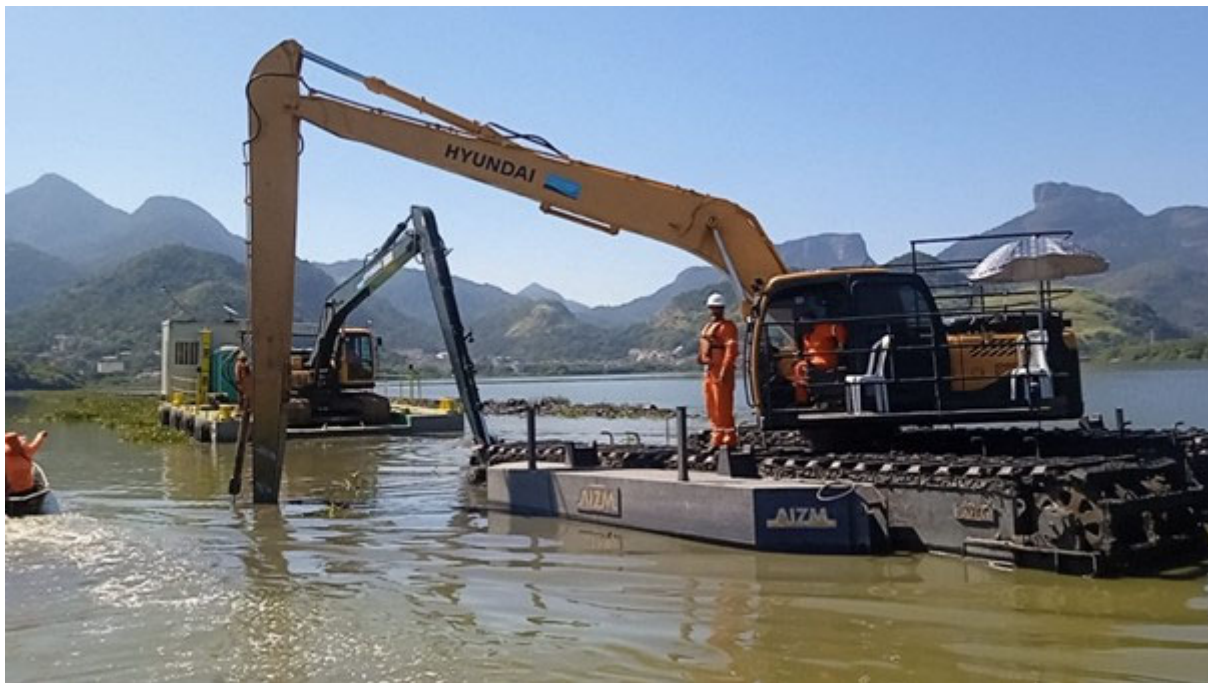
Foto 4 - Operação de dragagem de serviço. Em primeiro plano, uma escavadeira auto flutuante
