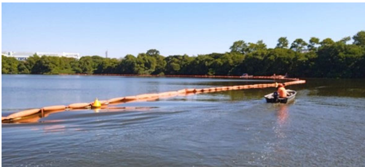
Foto 7 - Instalação de cortinas Antissiltagem
